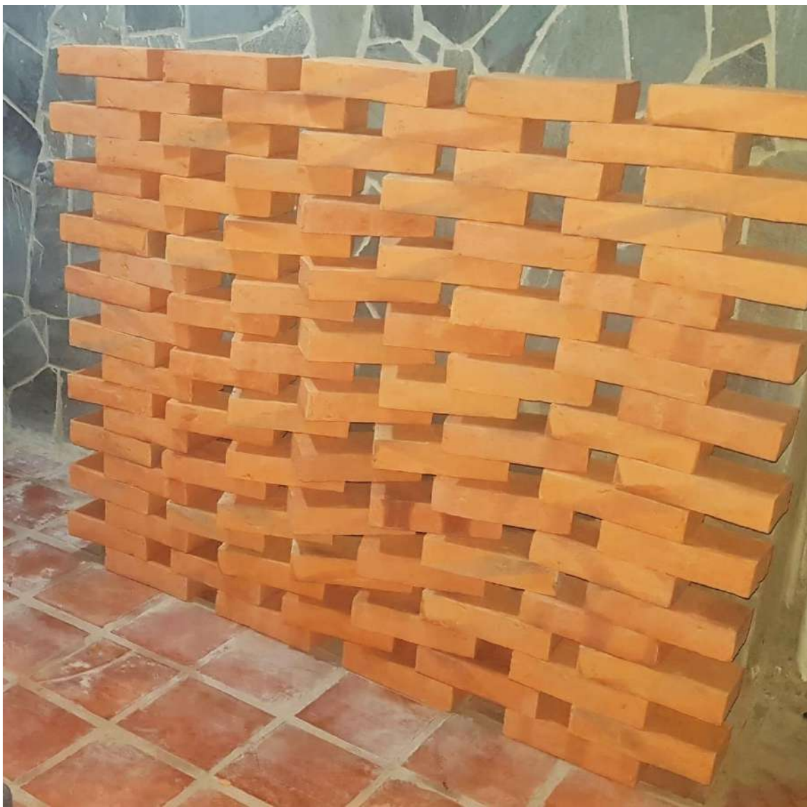
MURO PARAMÉTRICO CONSTRUIDO CON PLANTILLAS DE VENESTA
