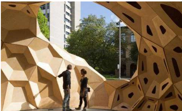
Método constructivo teselado irregular
