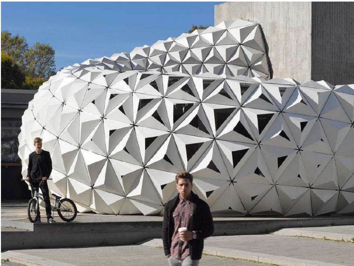
“ArboSkin - fachada de bioplástico” desarrollado por el Institute of Building Structures and Structural Design (ITKE) de la Universidad de Stuttgart - Alemania
