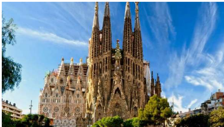
Sagrada familia iniciada en 1882 todavía esta en construcción
