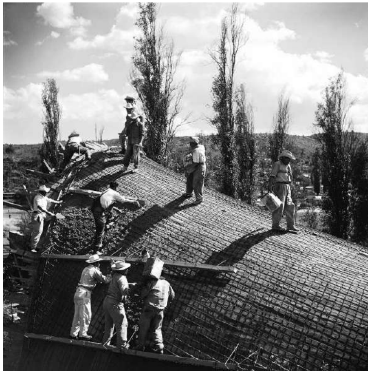
Encofrado para el Restaurante Los Manantiales. Xochi-milco, México. Félix Candela, 1958.
