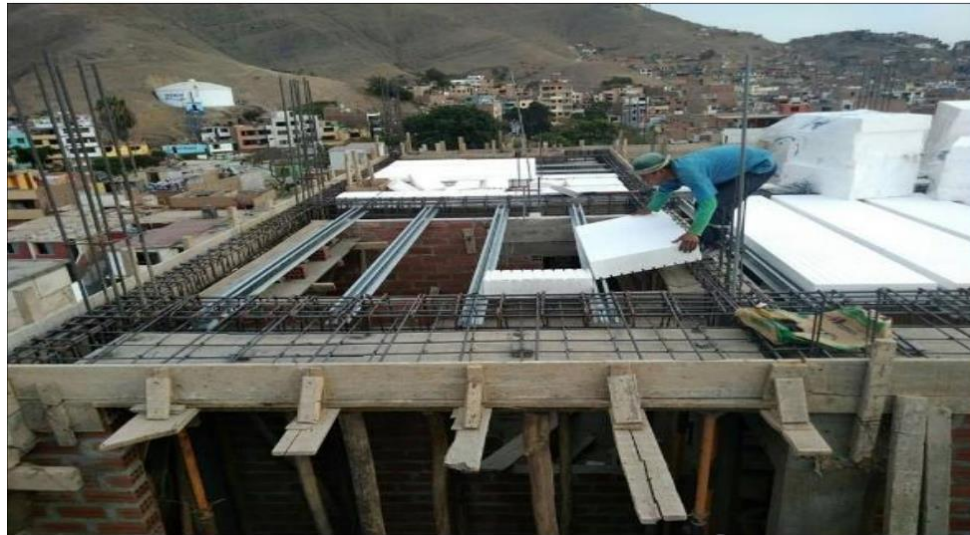
FIGURA 4. 2 Instalado de Losa Aligerada
