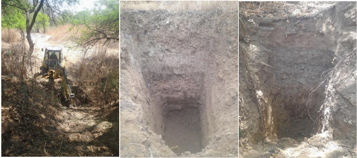
Figura 3.4 Fotografías de la excavación de los pozos
