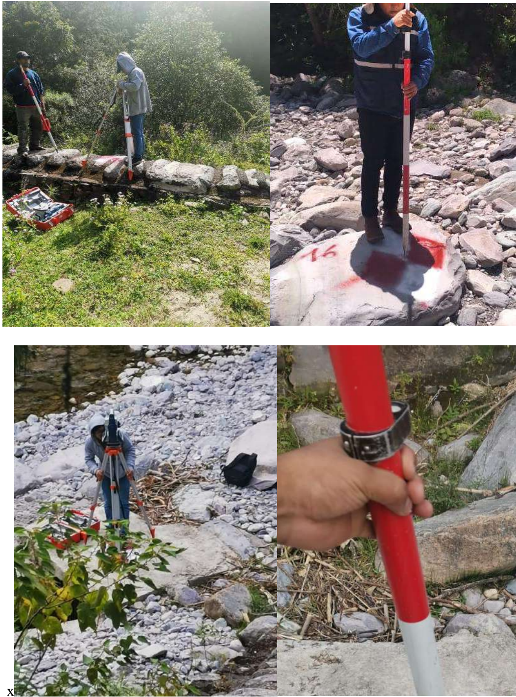
Figura 55: levantamiento de coordenadas de los puntos de control con estación total y GPS RTK.
