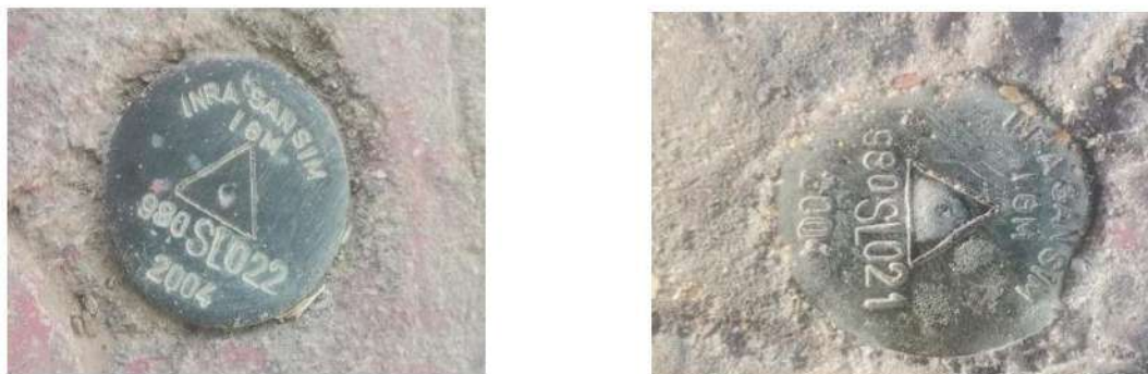
Figura 51: Par Geodésico utilizado para la georreferenciación del presente proyecto.
