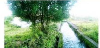
CANALES DE AGUA
