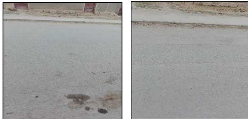
Imagen 26: Lugar de muestra N 26, Municipio de Padcaya, PCI: EXCELENTE
