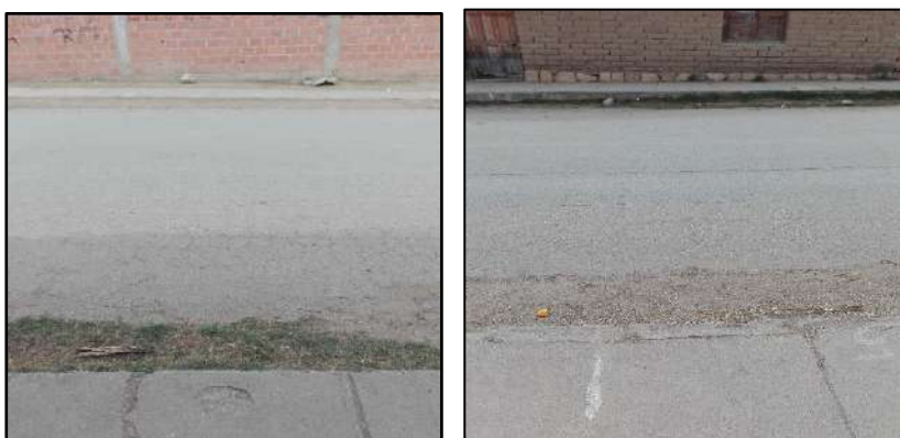
Imagen 28: Lugar de muestra N 28, Municipio de Padcaya, PCI: MUY BUENO
