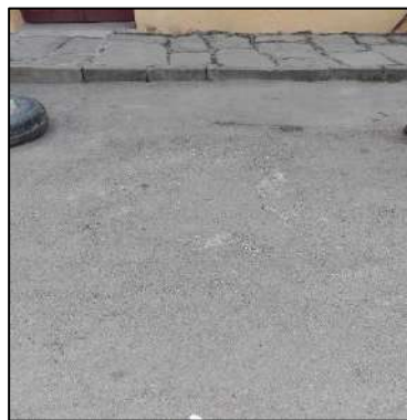
Imagen 9: Lugar de Muestra N9. Municipio de Padcaya, PCI: MUY BUENO.
