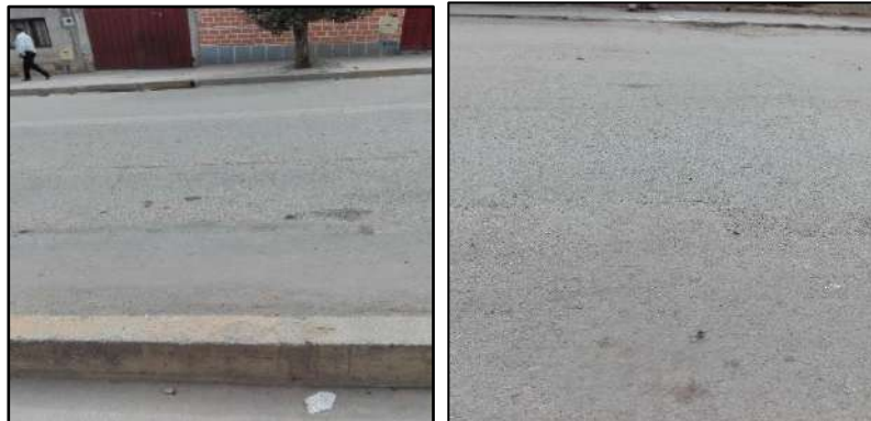
Imagen 23: Lugar de muestra N 23, Municipio de Padcaya, PCI: REGULAR
