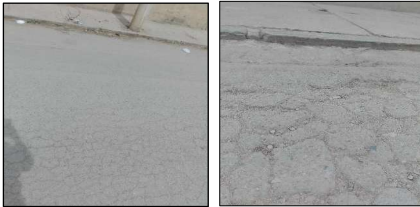
Imagen 25: Lugar de muestra N 25, Municipio de Padcaya, PCI: MALO
