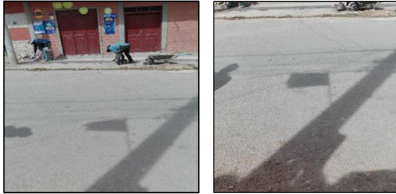
Imagen 21: Lugar de muestra N 21, Municipio de Padcaya, PCI: MUY BUENO
