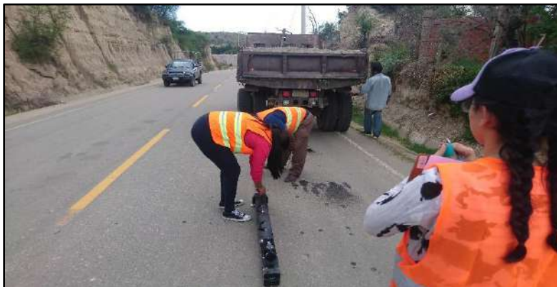
Imagen 3: Se hace coincidir la Viga benkelman con el centro de gravedad
