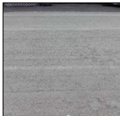
Imagen 9: Lugar de Muestra N9. Municipio de Padcaya, PCI: MUY BUENO.
