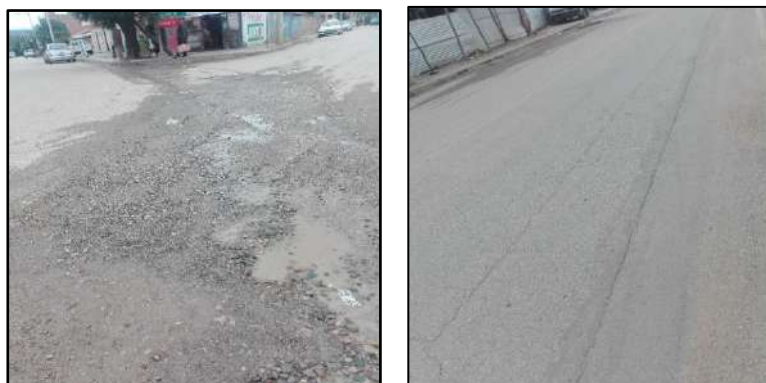
Imagen 36: Lugar de muestra N 36, Municipio de Padcaya 2019, PCI: REGULAR
