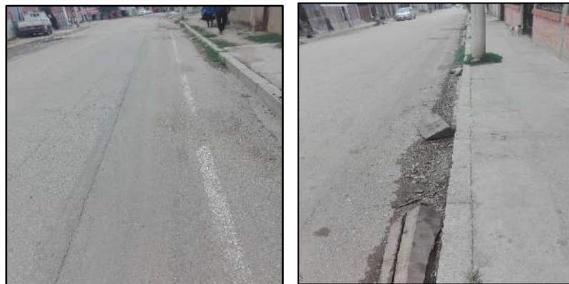
Imagen 35: Lugar de muestra N 35, Municipio de Padcaya 2019, PCI: BUENO
