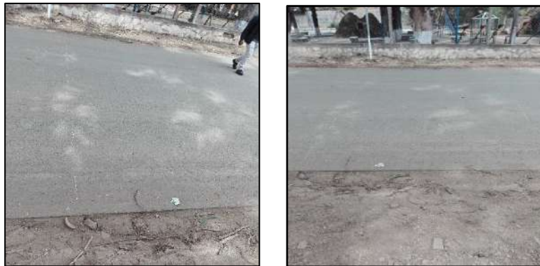
Imagen 2: Lugar de muestra N 2, Municipio de Padcaya 2019, PCI: MUY BUENO.
