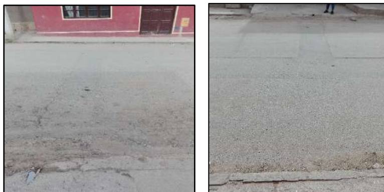
Imagen 27: Lugar de muestra N 27, Municipio de Padcaya, PCI: REGULAR
