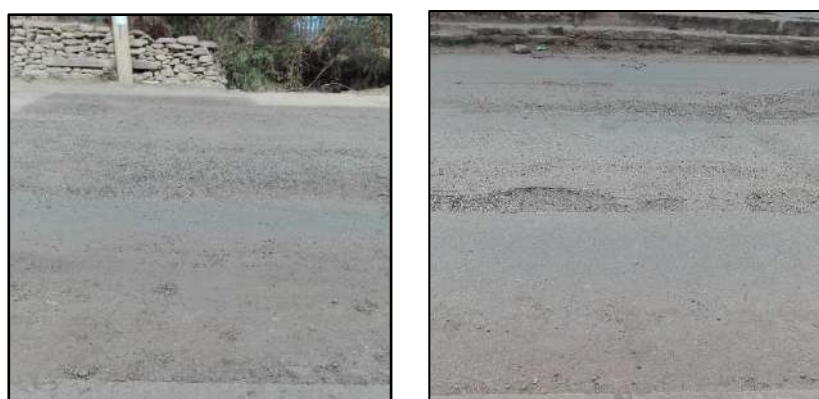
Imagen 14: Lugar de Muestra N 14, Municipio de Padcaya, PCI: MUY BUENO
