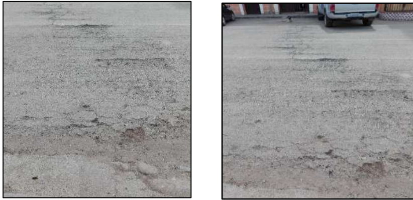
Imagen 10: Lugar de Muestra N 10, Municipio de Padcaya, PCI: MUY MALO
