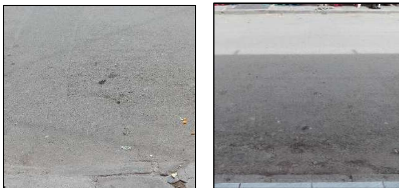
Imagen 12:Lugar de Muestra N 12, Municipio de Padcaya, PCI: BUENO.
