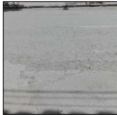
Imagen 8: Lugar de Muestra N 8, Municipio de Padcaya, PCI: MUY MALO.
