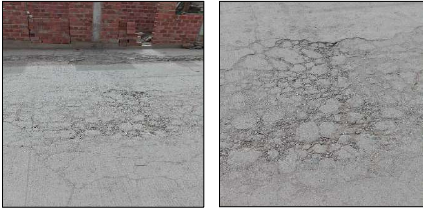
Imagen 15: Lugar de Muestra N 15, Municipio de Padcaya, PCI: MUY MALO
