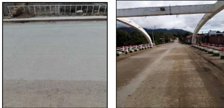
Imagen 5: Lugar de muestra N 5, Municipio de Padcaya 2019, PCI: MUY BUENO
