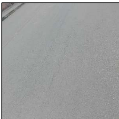
Imagen 31: Lugar de muestra N 31, Municipio de Padcaya 2019, PCI: EXCELENTE
