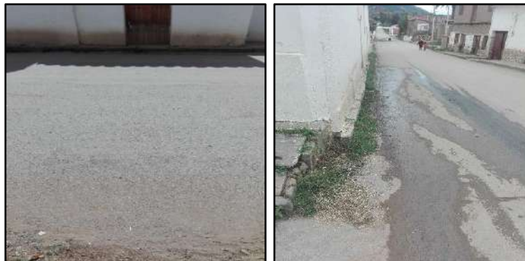
Imagen 6: Lugar de muestra N 6, Municipio de Padcaya 2019, PCI: EXCELENTE.
