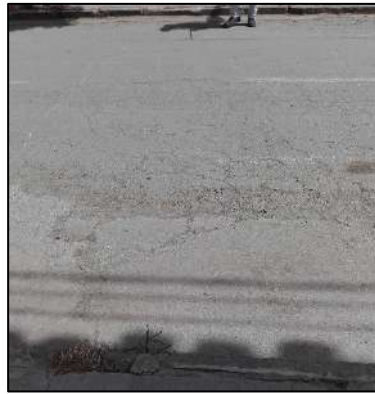
Imagen 8: Lugar de Muestra N 8, Municipio de Padcaya, PCI: MUY MALO.
