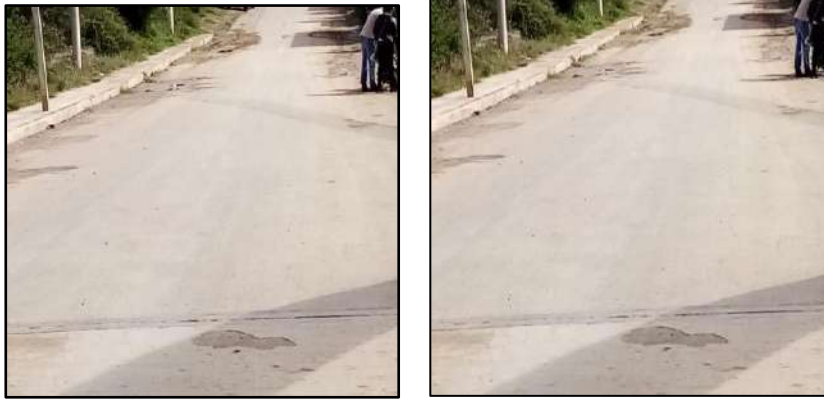
Imagen 4: Lugar de muestra N 4, Municipio de Padcaya 2019. PCI: EXCELENTE
