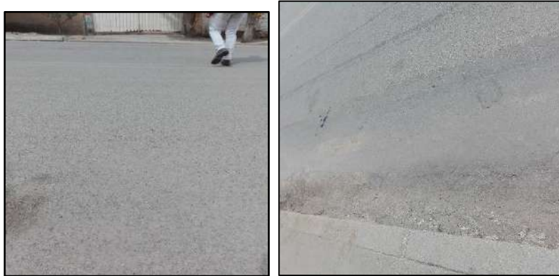
Imagen 22: Lugar de muestra N 22, Municipio de Padcaya, PCI: EXCELENTE
