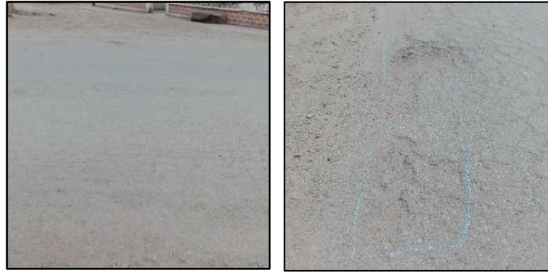
Imagen 18: Lugar de muestra N 18, Municipio de Padcaya, PCI: REGULAR
