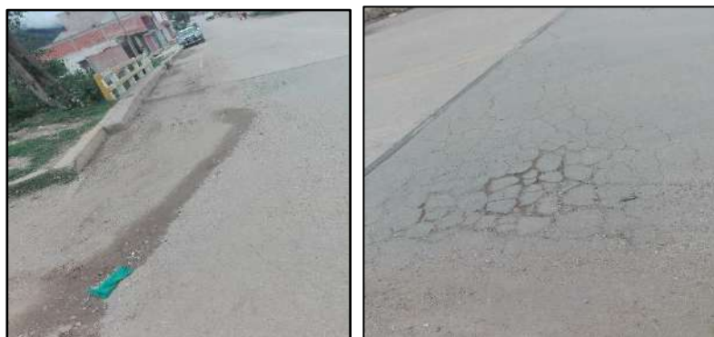
Imagen 32: Lugar de muestra N 32, Municipio de Padcaya 2019, PCI: BUENO
