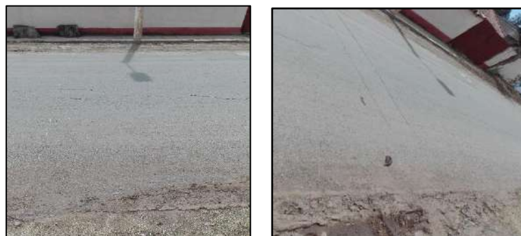
Imagen 3: Lugar de muestra N 3, Municipio de Padcaya 2019. PCI: MUY BUENO
