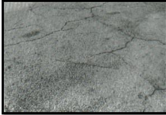
Figura 18 Grietas en bloque de severidad media
