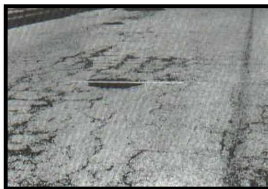
Figura 46 Hueco de severidad media
