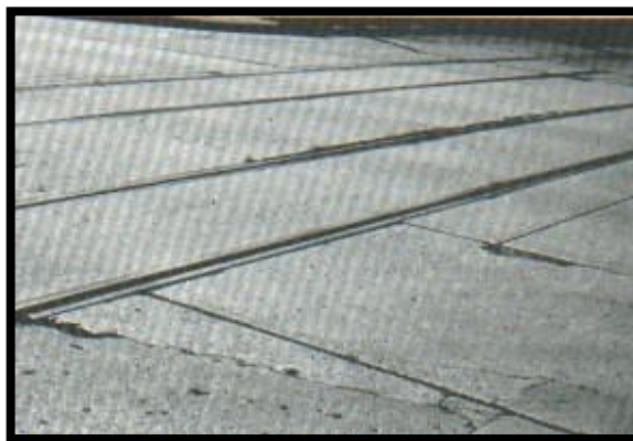
Figura 101 Cruce de vía férrea de baja severidad
