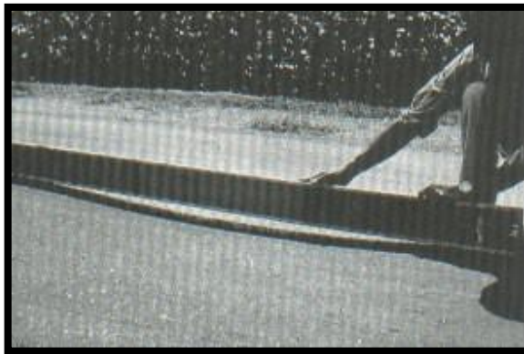
Figura 28 Depresión de alta severidad
