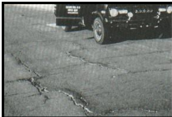
Figura 19 Grietas en bloque de alta severidad
