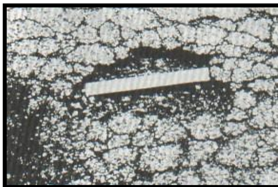
Figura 46 Hueco de severidad media
