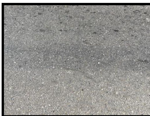
Figura 162 Grieta de severidad baja, ubicada en el tramo inclinado
