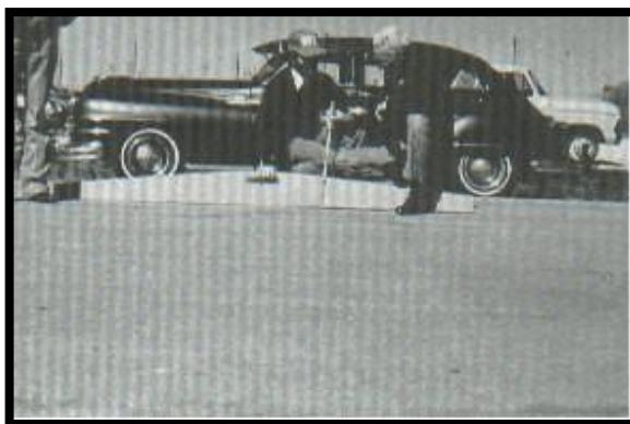
Figura 26 Depresión de baja severidad
