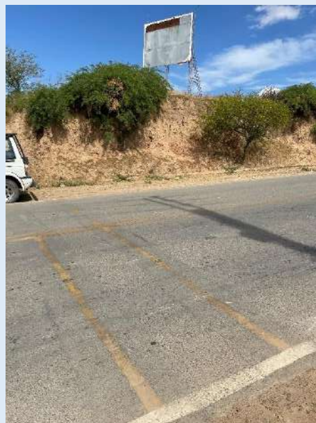
Agrietamientos leves
