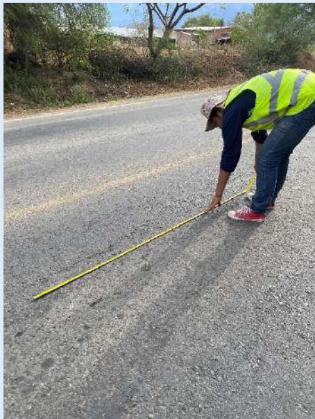
Punto de medición de falla
