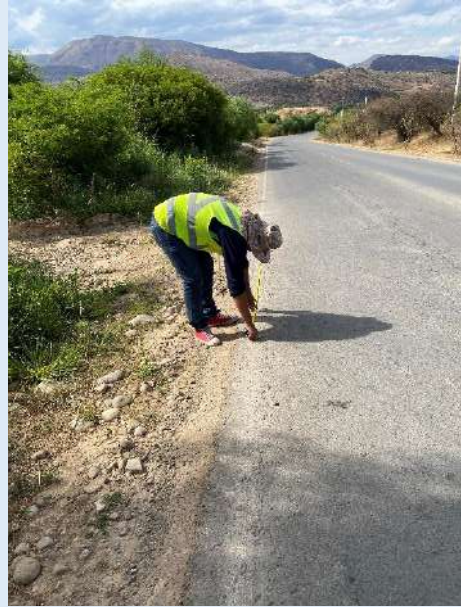
Punto de medición de la falla
