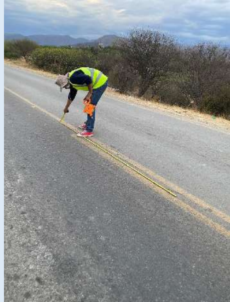
Punto de medición de falla
