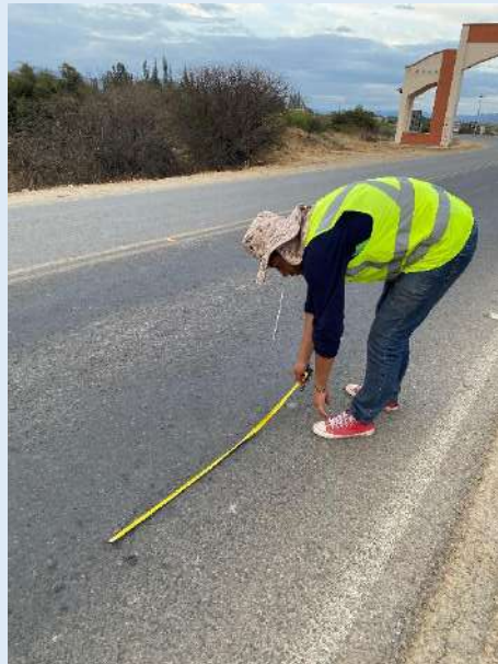
Punto de medición de falla
