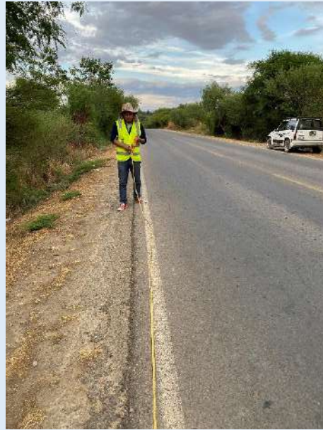
Punto de medición de falla
