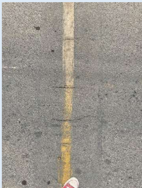
Agrietamientos leves
