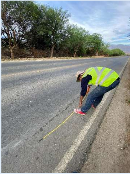
Punto de medición de falla
