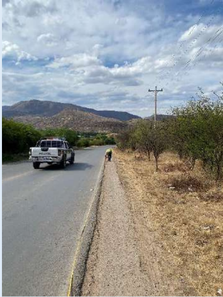
Punto de medición de la falla
