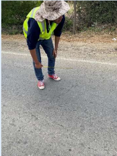
Punto de medición de falla
