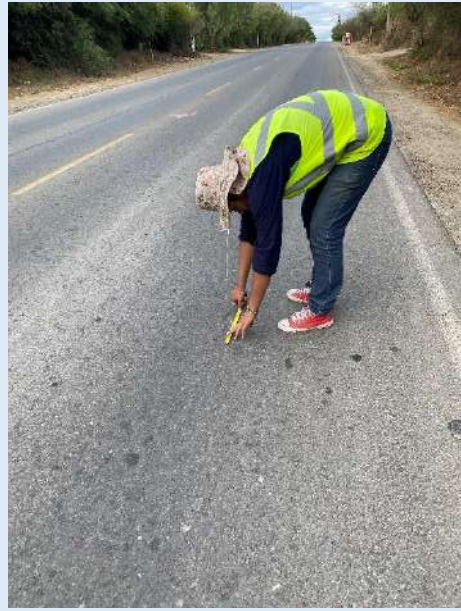
Punto de medición de falla
