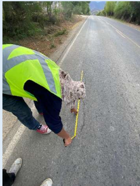
Punto de medición de falla
