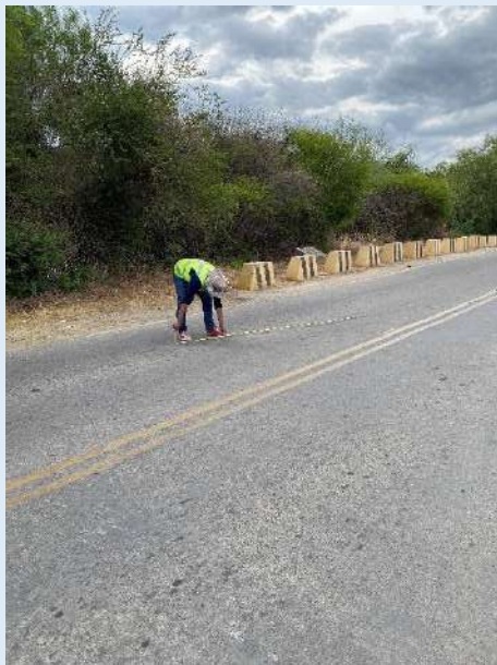
Punto de medición de falla
