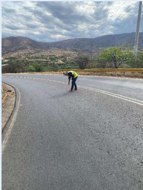
Punto de medición de falla
