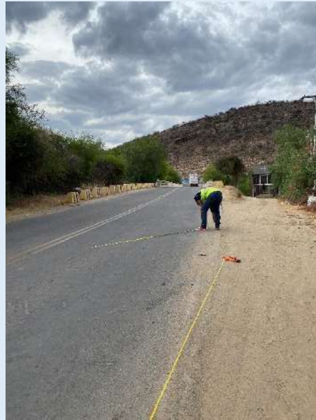
Punto de medición de falla
