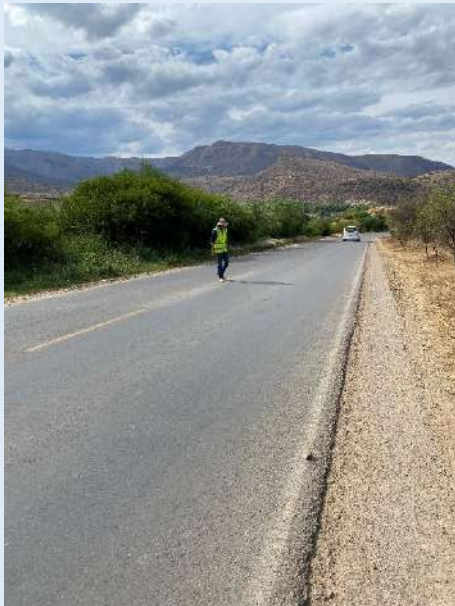
Punto de inspección tramo
