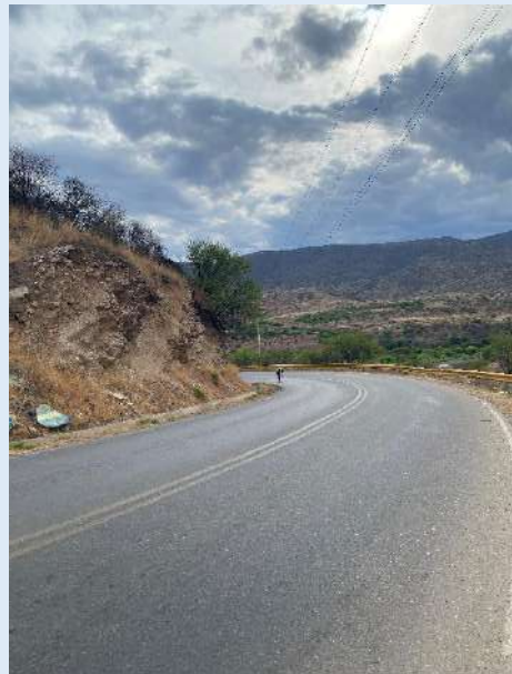
Punto de medición de falla
