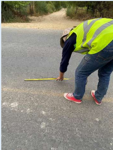
Punto de medición de falla
