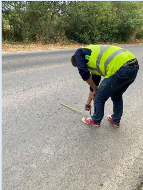
Punto de medición de falla
