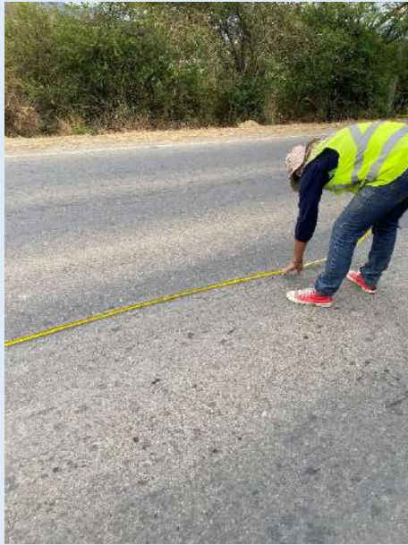
Punto de medición de falla
