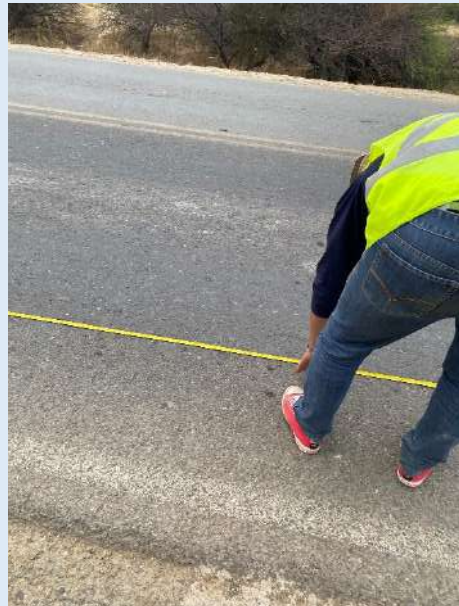
Punto de medición de falla
