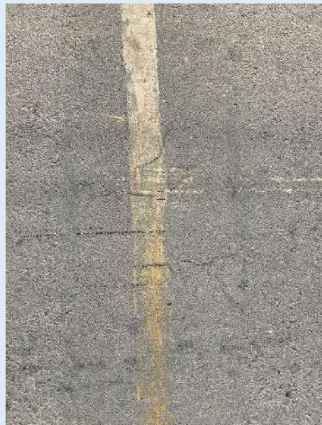
Agrietamientos leves
