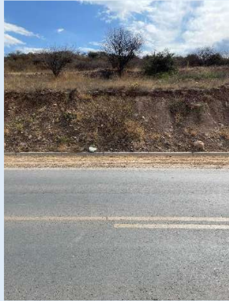
Punto de inspección tramo
