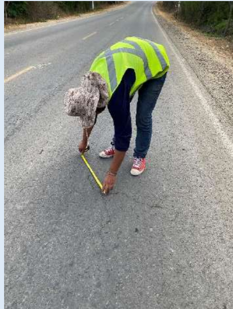
Punto de medición de falla
