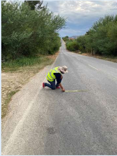
Punto de medición de falla
