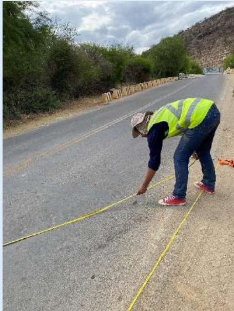
Punto de medición de falla
