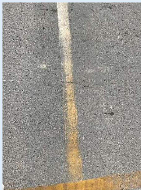
Agrietamientos leves
