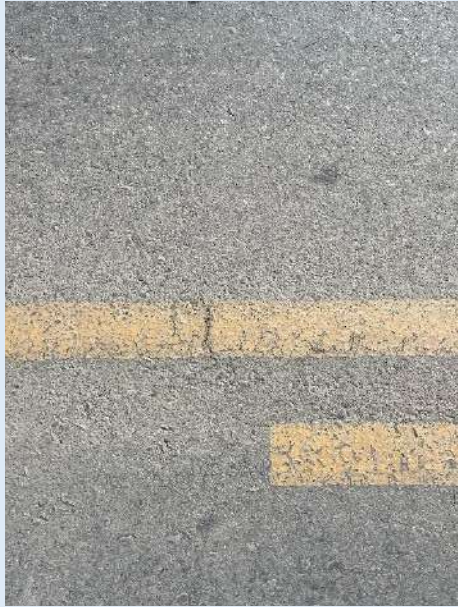
Punto de inspección tramo
