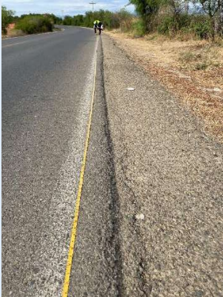
Agrietamientos leves
