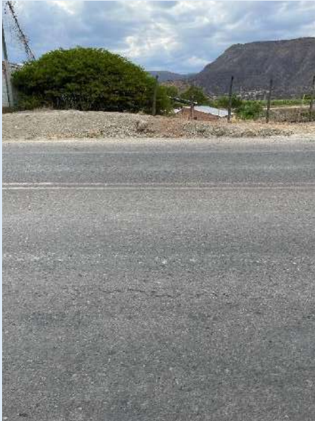
Agrietamientos leves
