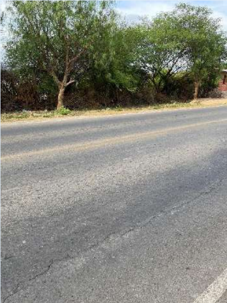
Agrietamientos leves
