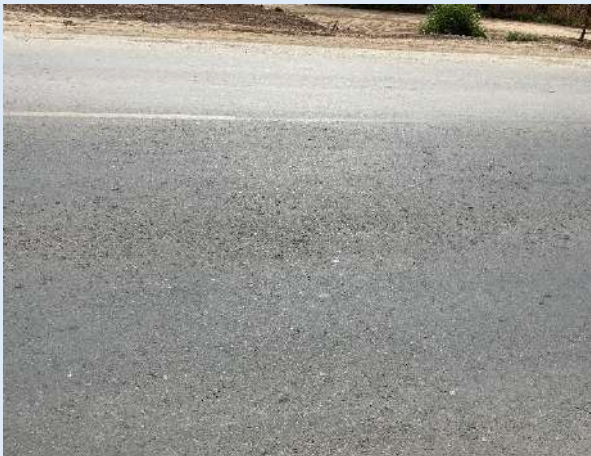
Agrietamientos leves
