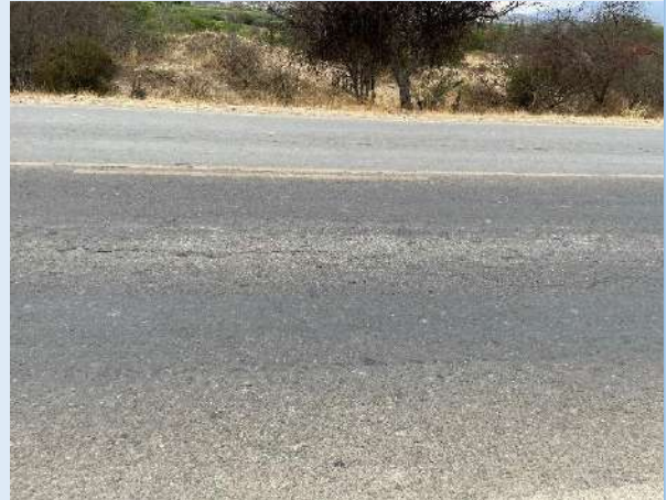
Agrietamientos leves
