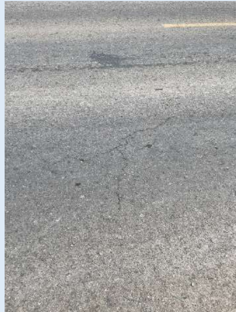
Agrietamientos leves
