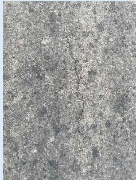
Agrietamientos leves
