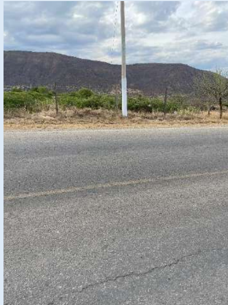
Agrietamientos leves
