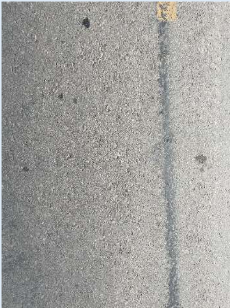
Agrietamientos leves
