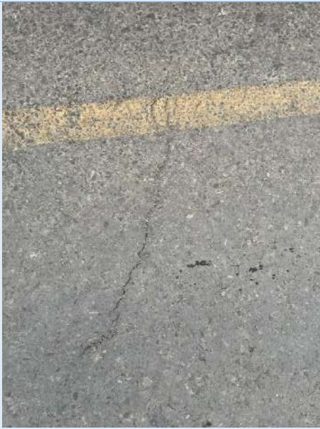
Agrietamientos leves
