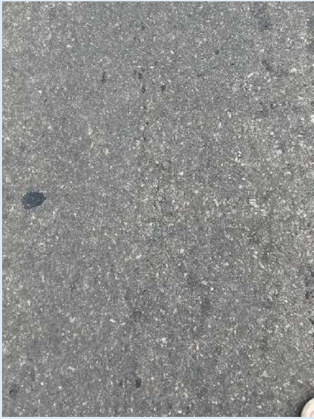
Agrietamientos leves
