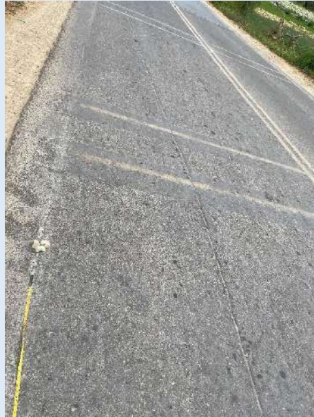
Agrietamientos medios
