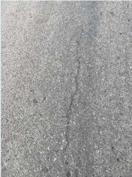
Agrietamientos leves
