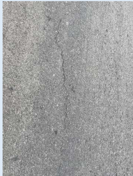
Agrietamientos leves
