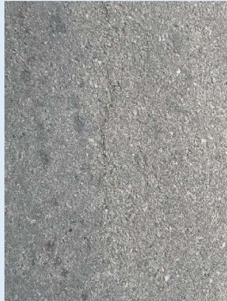
Agrietamientos leves
