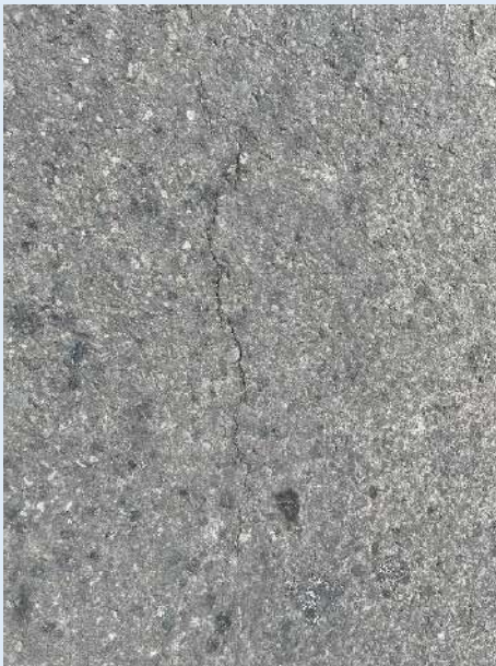
Agrietamientos leves
