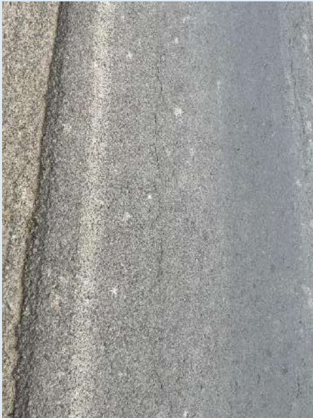
Agrietamientos leves
