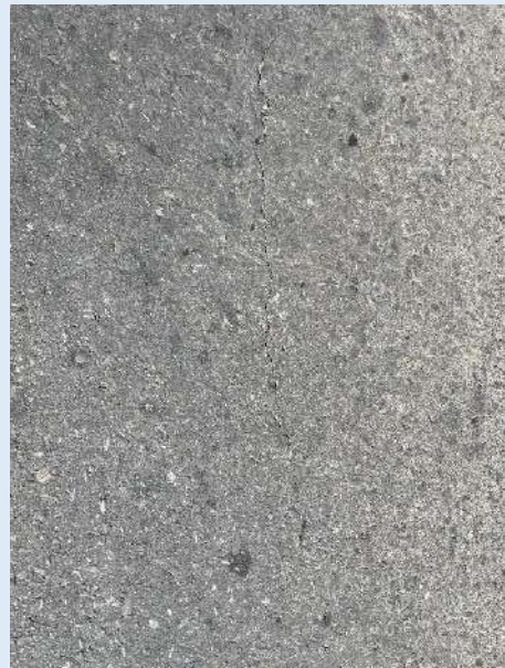
Agrietamientos leves
