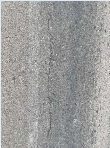
Agrietamientos leves
