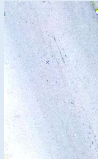
Falla: 10 M ,Cantidad: 3.921
