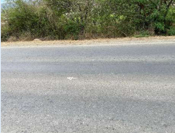
Agrietamientos leves
