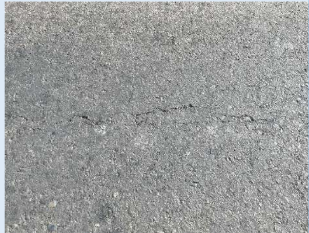
Agrietamientos leves
