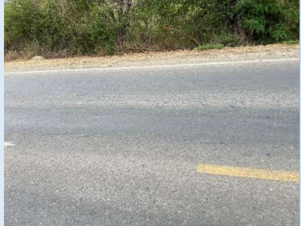
Agrietamientos leves
