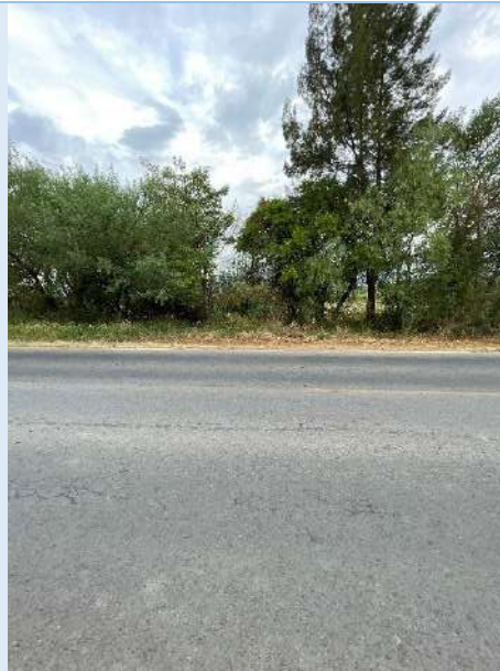
Agrietamientos leves
