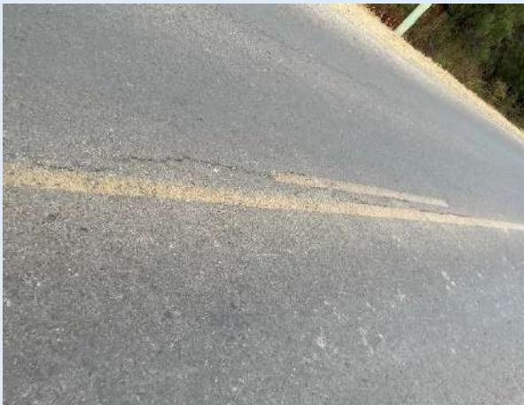
Agrietamientos leves
