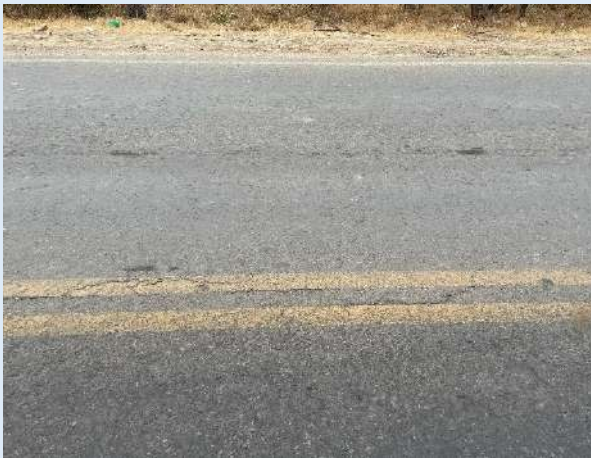
Agrietamientos leves
