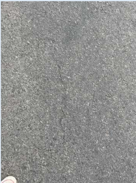
Agrietamientos leves
