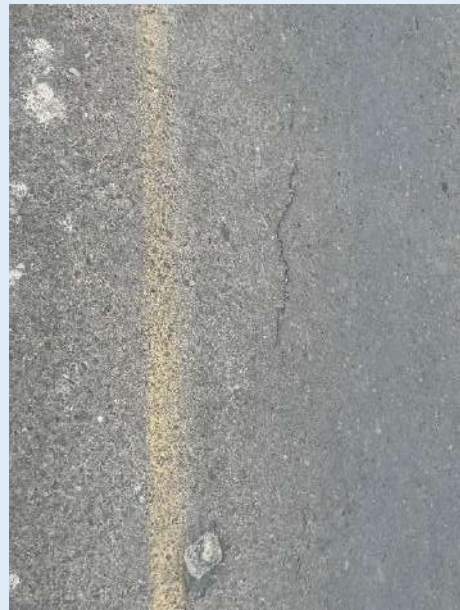
Agrietamientos leves
