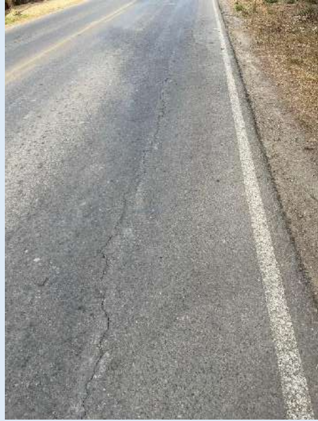
Agrietamientos leves
