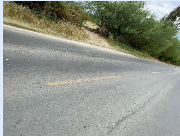
Agrietamientos leves
