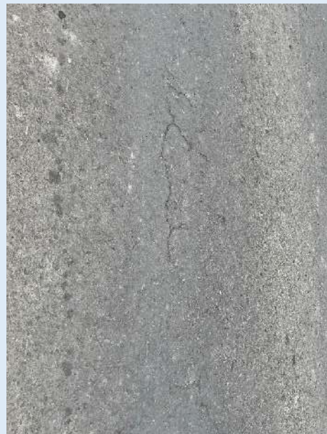
Agrietamientos leves
