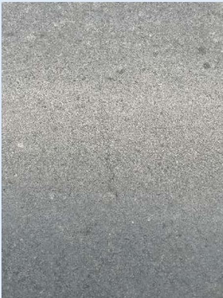
Agrietamientos leves
