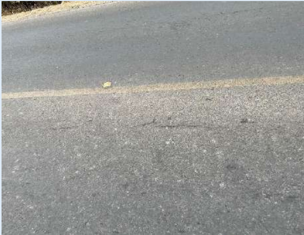
Agrietamientos leves
