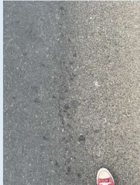
Agrietamientos leves
