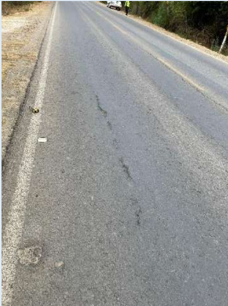
Agrietamientos leves
