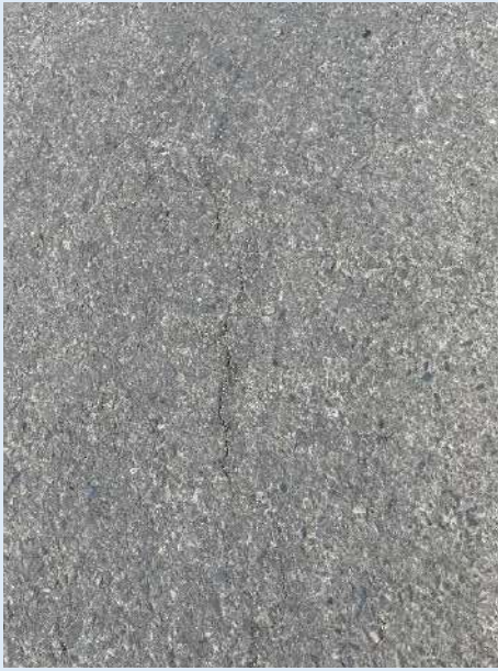
Agrietamientos leves
