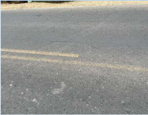
Agrietamientos leves
