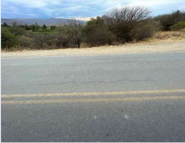
Agrietamientos leves
