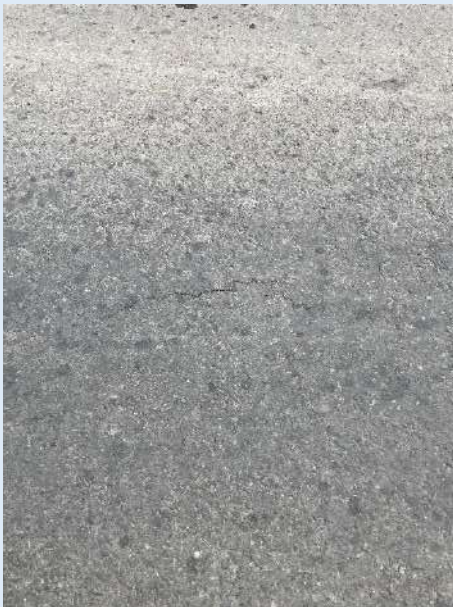
Agrietamientos leves
