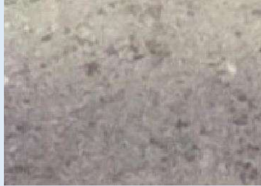
Falla: 10 M ,Cantidad: 1.01
