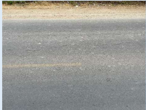
Agrietamientos leves
