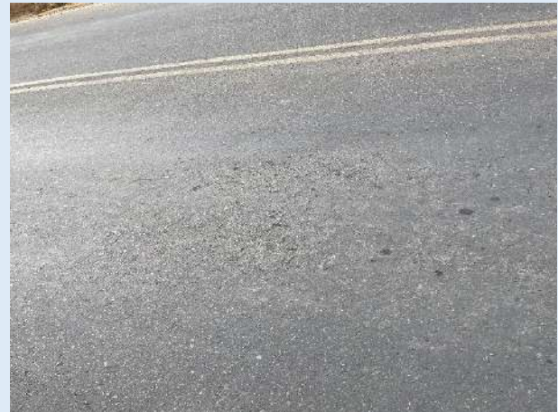
Agrietamientos leves
