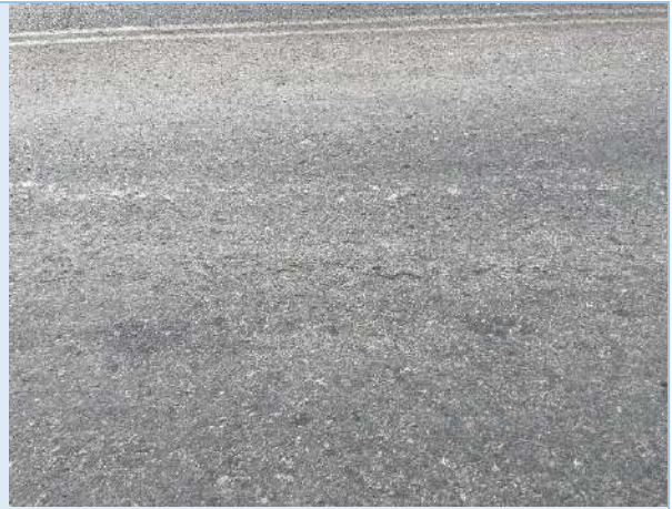
Agrietamientos leves
