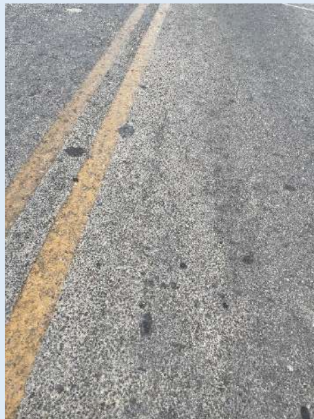
Agrietamientos leves
