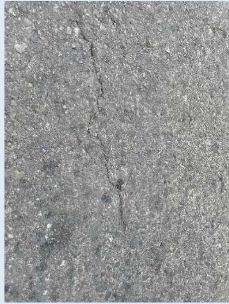
Agrietamientos leves
