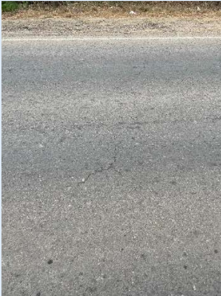
Agrietamientos leves
