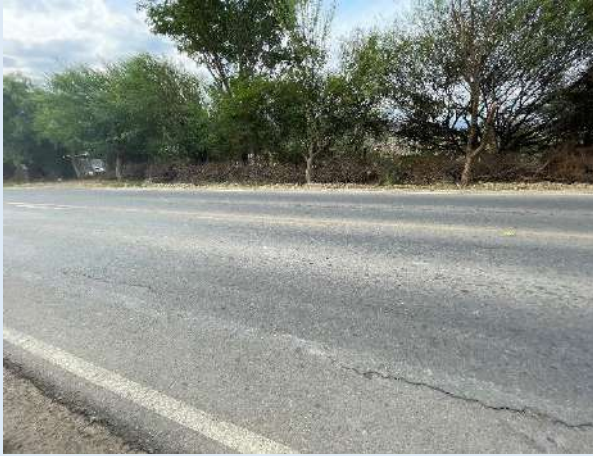
Agrietamientos leves
