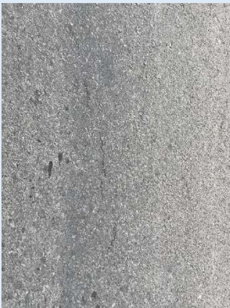
Agrietamientos leves
