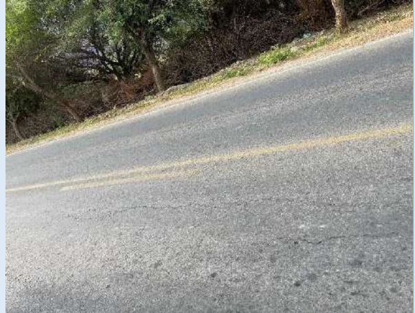
Agrietamientos leves
