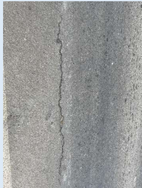
Agrietamientos leves
