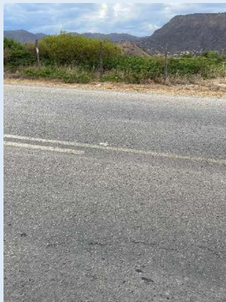
Agrietamientos leves
