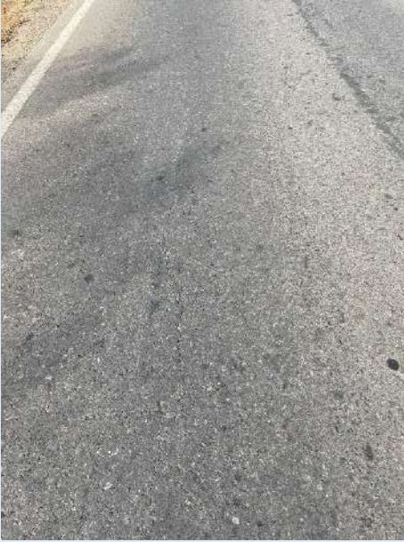
Agrietamientos leves
