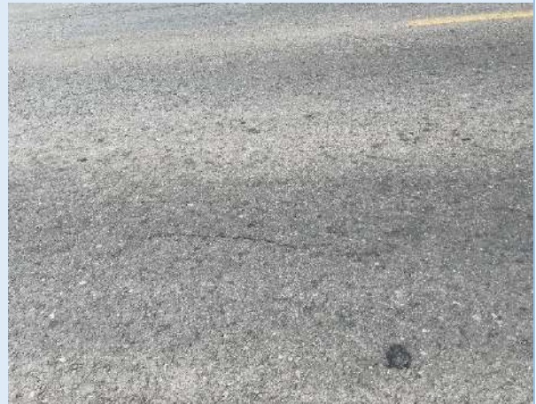
Agrietamientos leves
