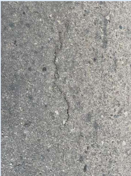
Agrietamientos leves
