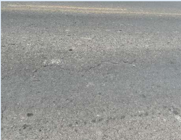
Agrietamientos leves
