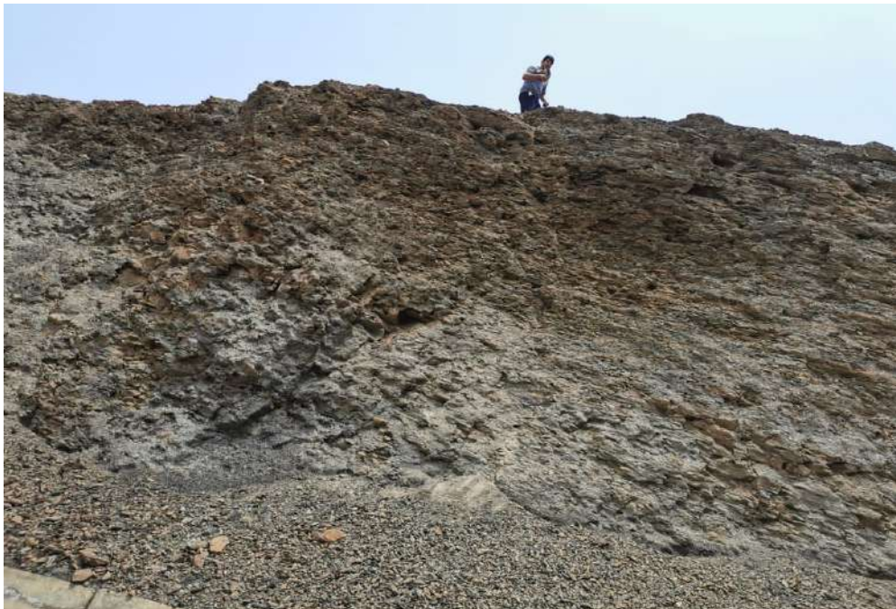
Figura 3.8. Extracción de muestra talud N°5 (cabeza)
