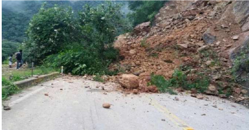
Figura 1.4. Deslizamiento presentado en la carretera Padcaya-Río negro
