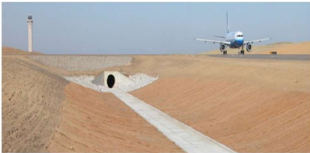
Figura 2.13. Protección de los taludes (Impermeabilización)
