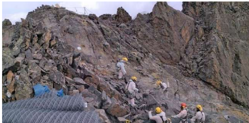
Figura 2.9. Colocación de malla
