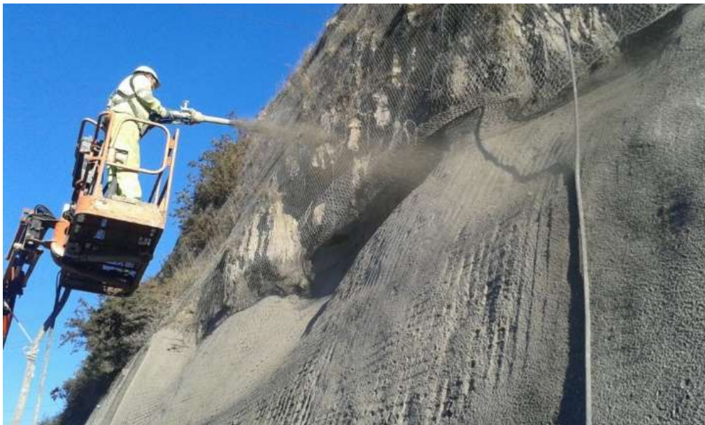
Figura 2.10. Técnica de hormigón proyectado
