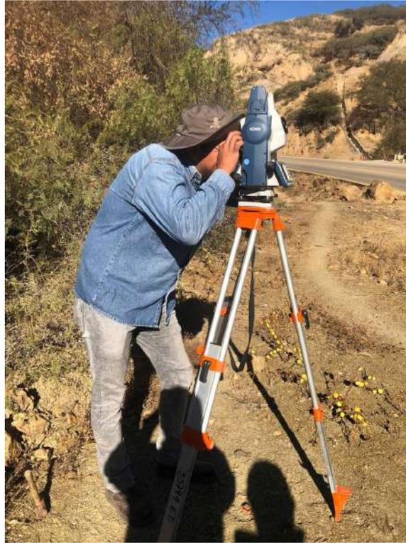
Fotografía 64. Levantamiento topográfico del talud N°4
