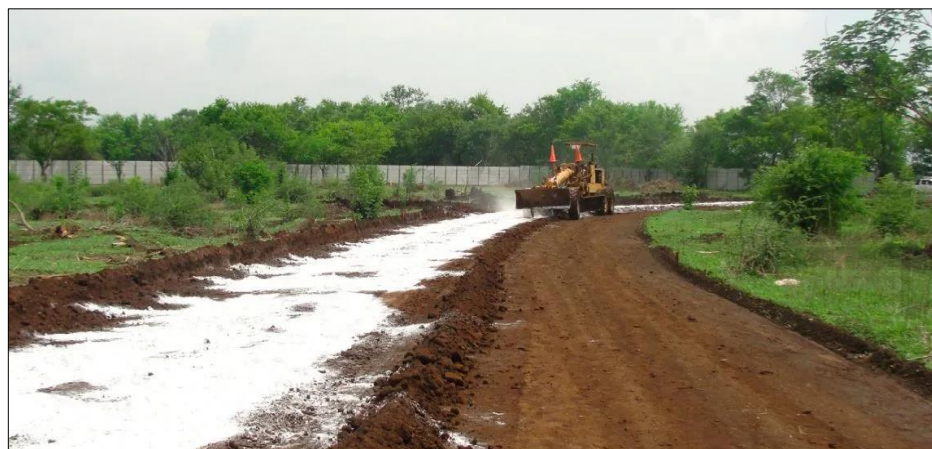
Figura 2.25 Estabilización del suelo con cal
