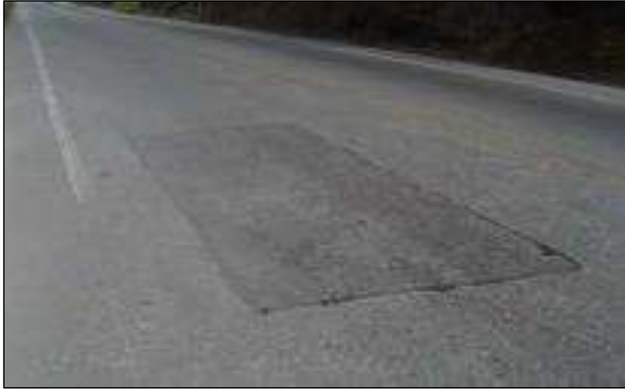
Figura 16 Parches deteriorados
