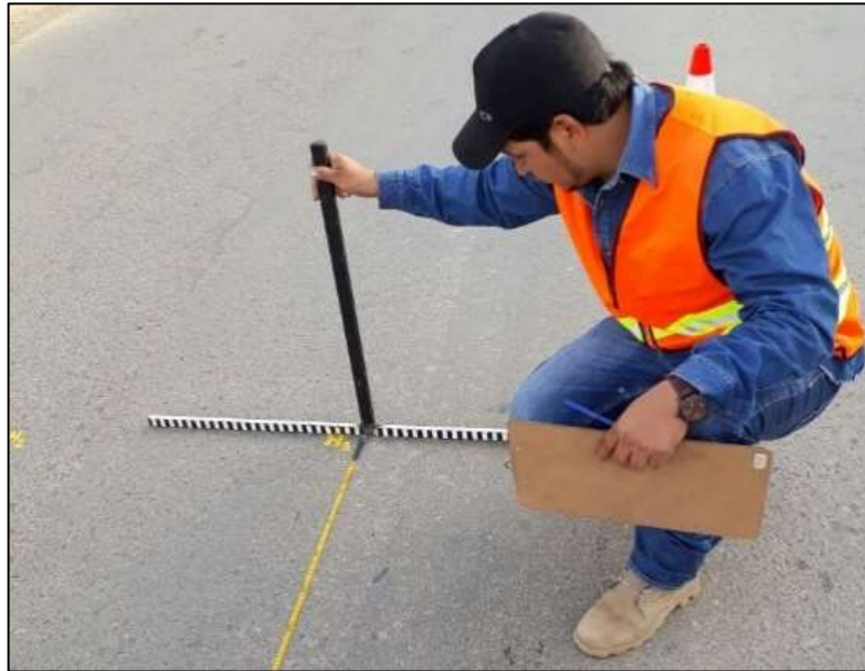
Figura 26 Medida del ahuellamiento zona avenida San Andrés
