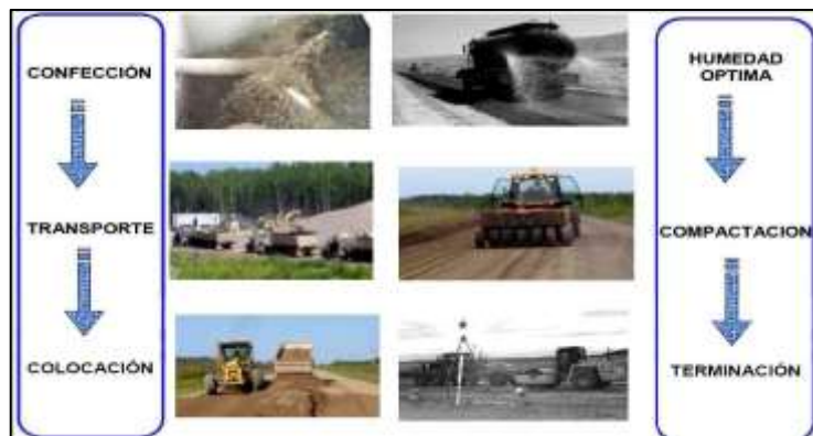
Figura 9 Etapas para la preparación de la base
