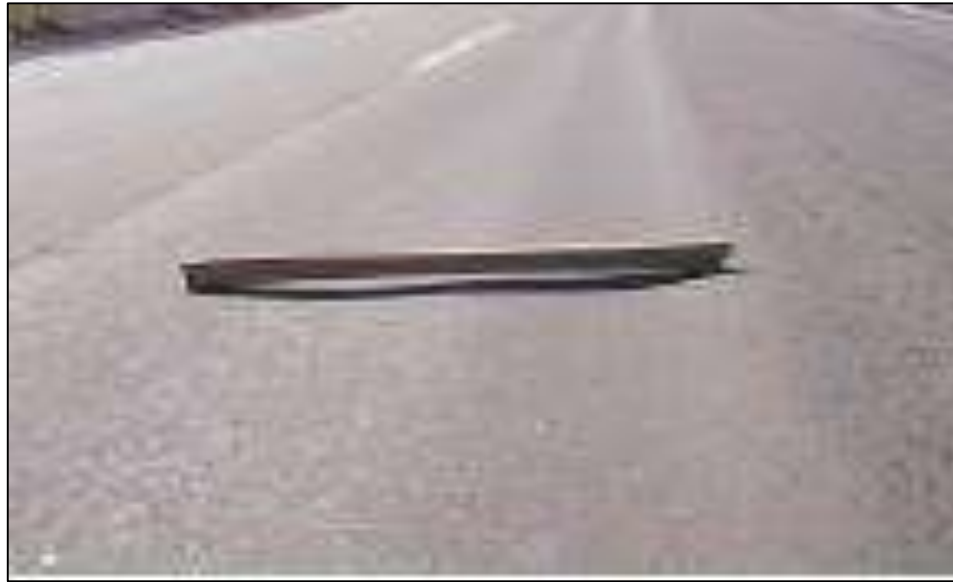
Figura 18 Ahuellamiento
