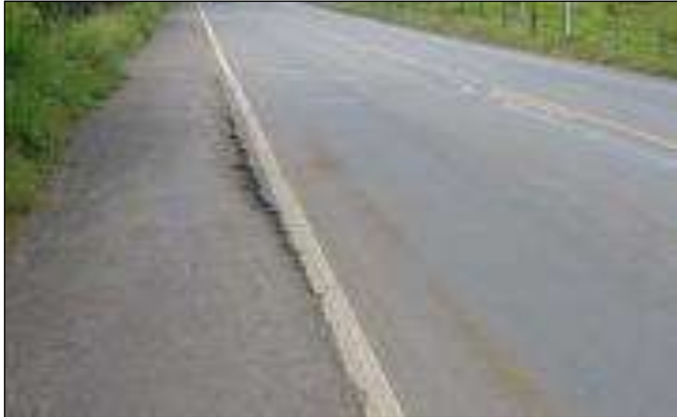
Figura 24 Descenso de berma
