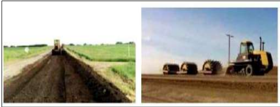
Figura 10 Etapas para la preparación de la sub-rasante
