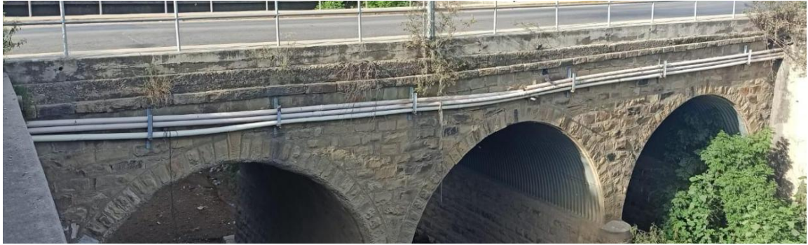
Figura 9. Tuberías de agua potable.
