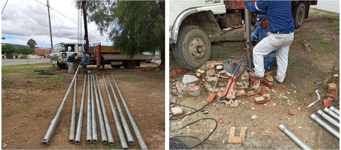
Ilustración 7. Instalación de electrobomba en el pozo. Fuente: Elaboración propia.
