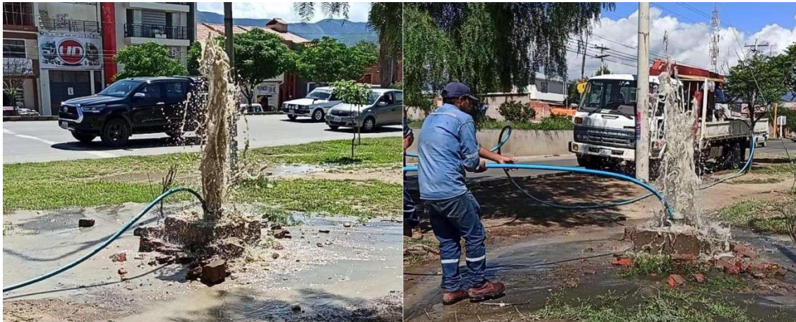
Ilustración 4. Pistoneo del pozo.
