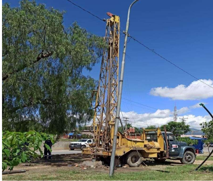
Ilustración 3. Cuchareo del pozo.
