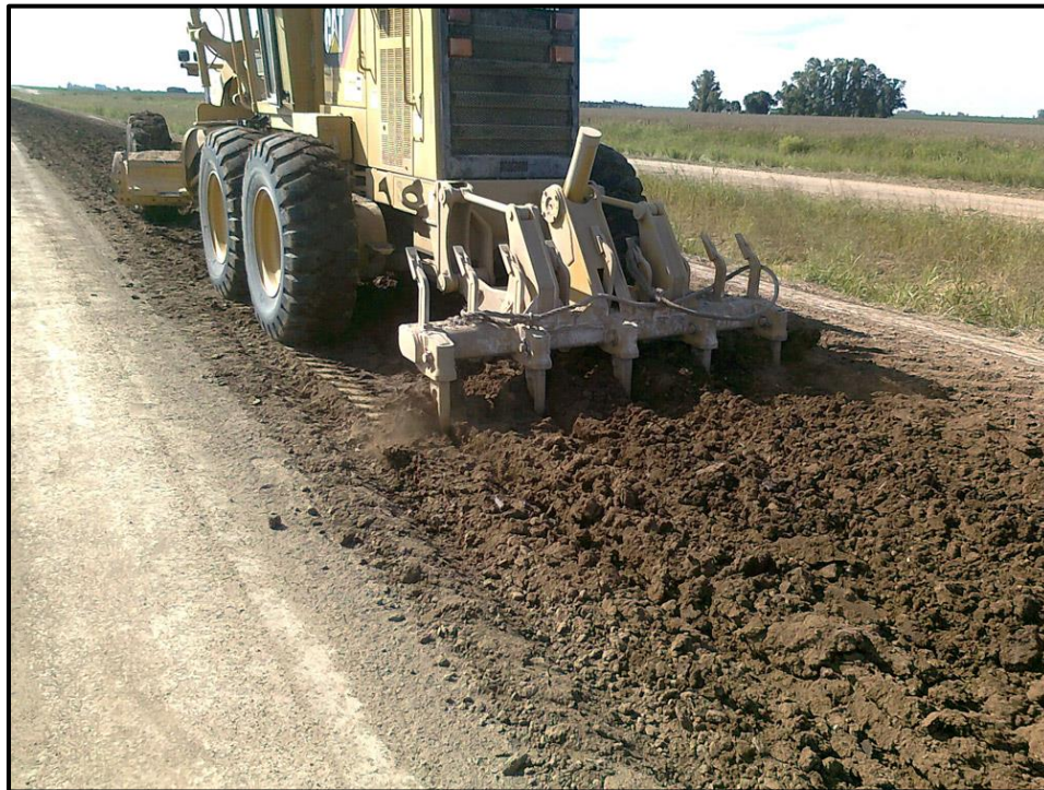
Figura 4.33: Escarificación del tramo a estabilizar
