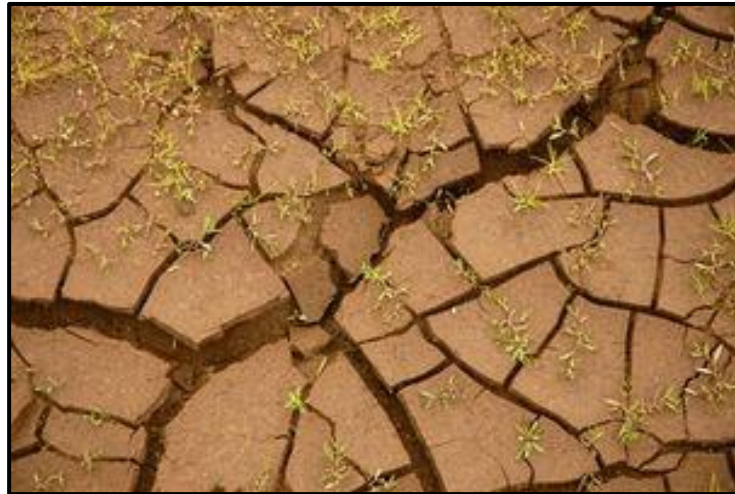
Figura 2.3: Suelo afectado por el cambio volumétrico
