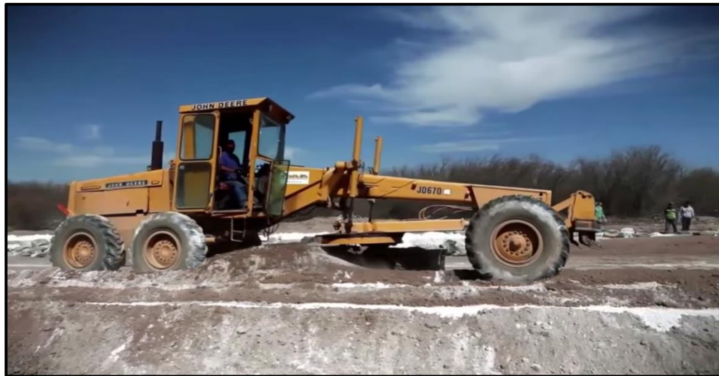
Figura 4.38: Mezcla y pulverización del suelo con la cal
