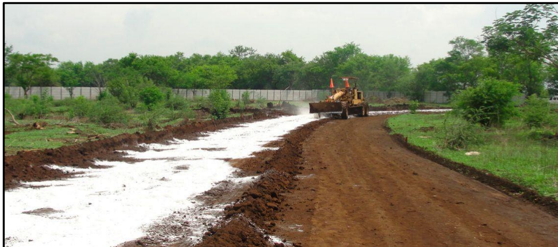
Figura 4.34: Aplicación de la cal
