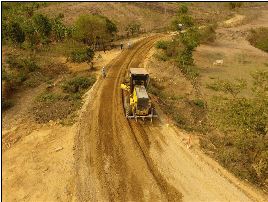
Figura 2.2: Estabilización de un tramo carretero
