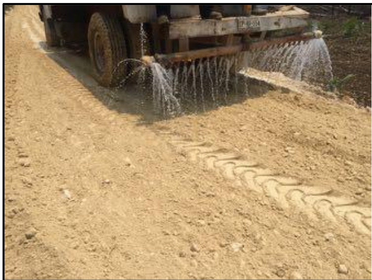
Figura 4.29: Regado del tramo a estabilizar
