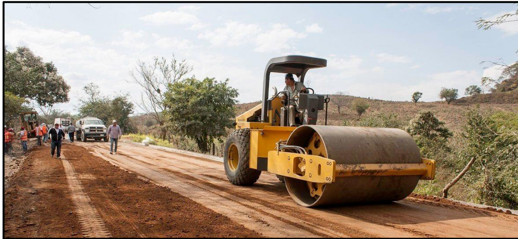
Figura 4.32: Compactación del suelo
