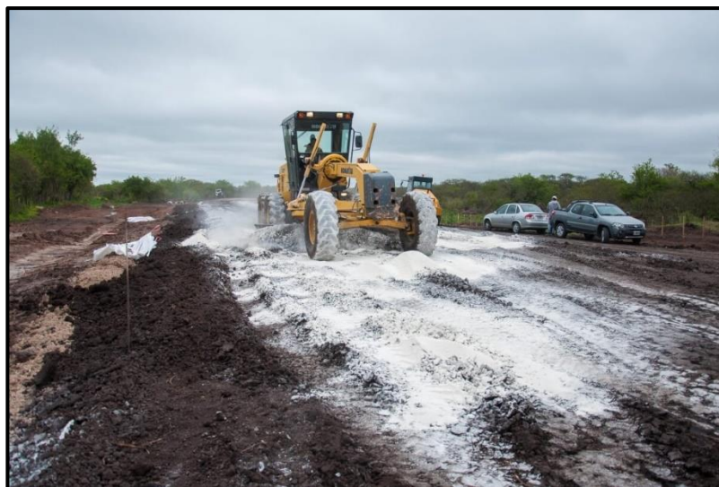
Figura 4.35: Mezcla del suelo con la cal
