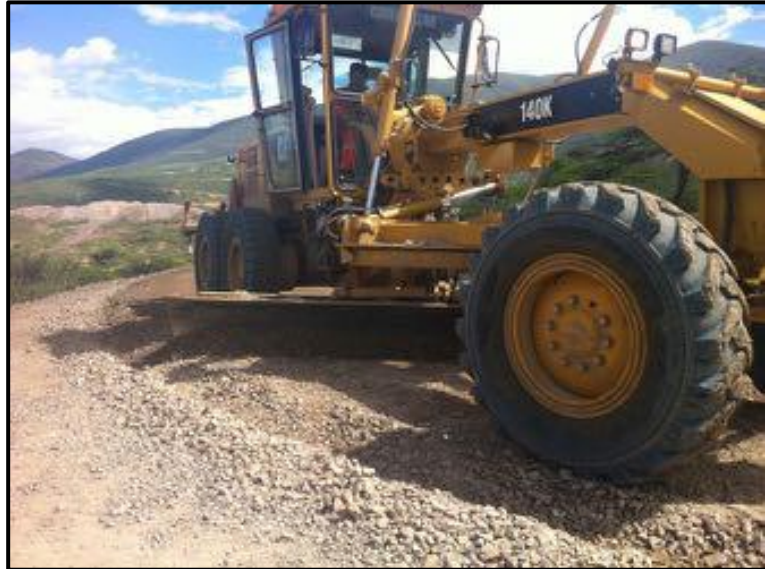
Figura 4.30: Mezclado del suelo con el aditivo
