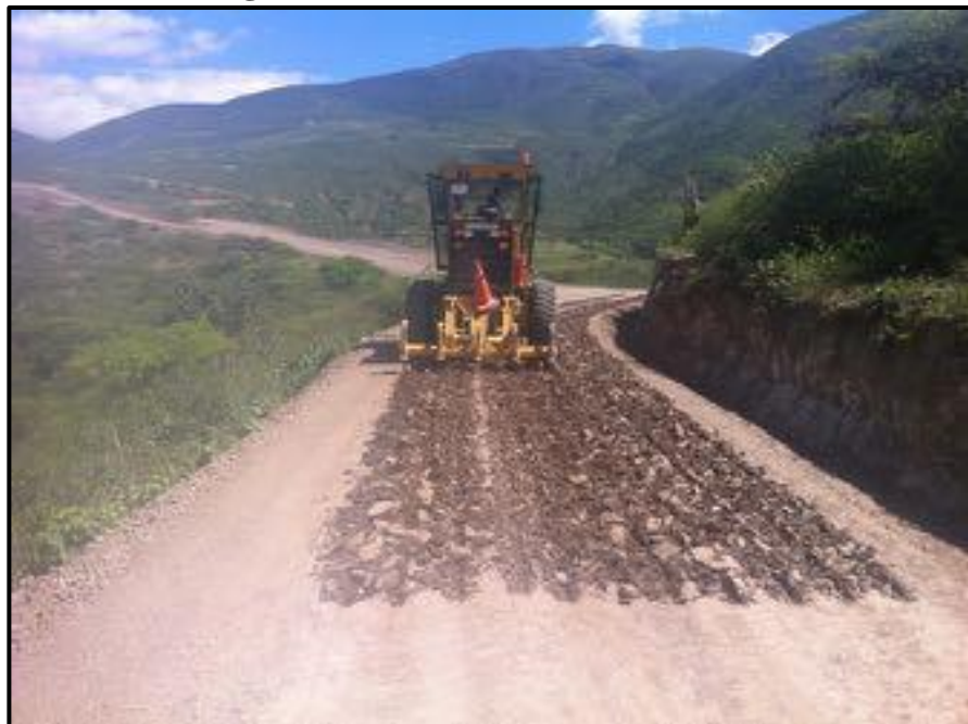
Figura 4.27: Proceso de escarificación
