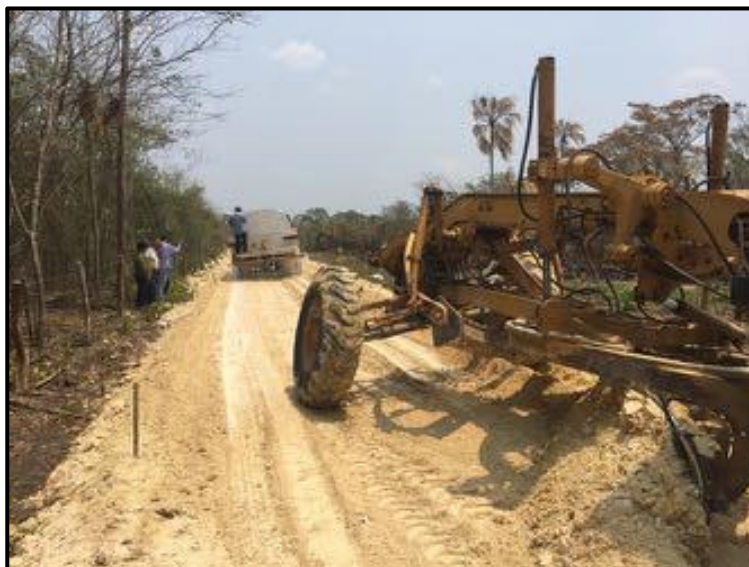
Figura 4.31: Nivelación y perfilación
