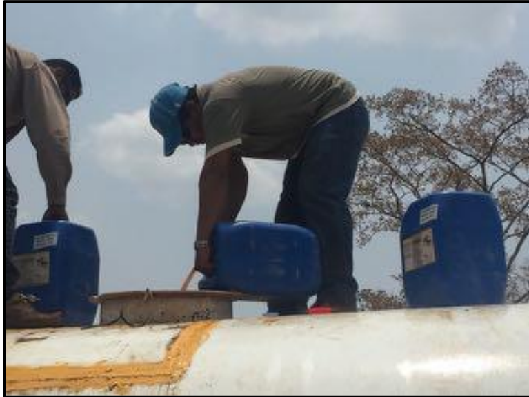
Figura 4.28: Llenado de agua a la cisterna junto con los aditivos
