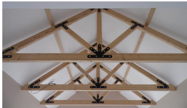
Figura 2.1 Fotografía de una cercha en un techo
