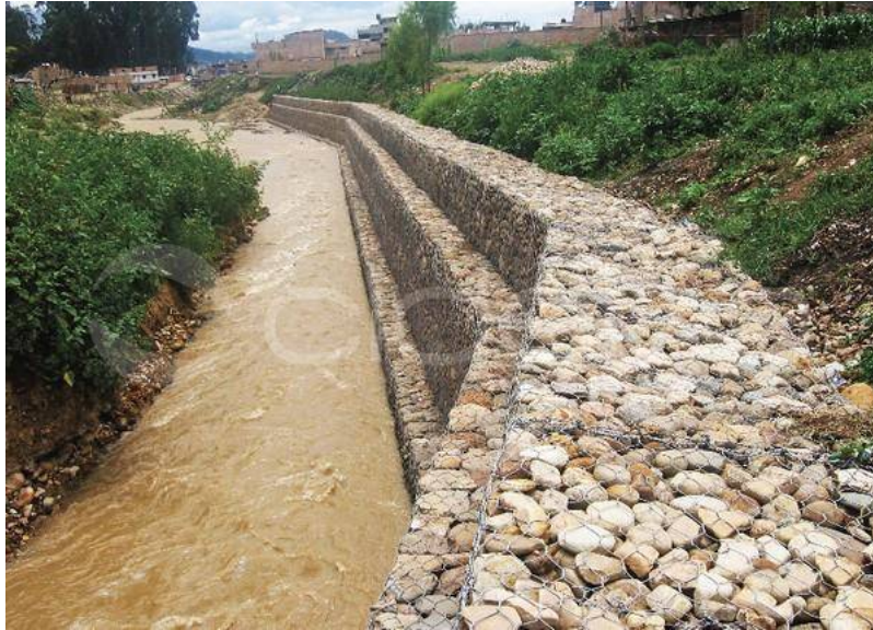
Figura 4 Gavión lateral en un cauce natural.
