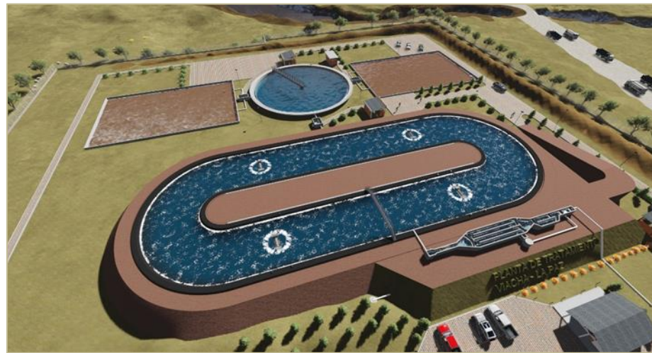
Figura 7: Vista en planta- Zanja de oxidación en la PTAR. Fuente: https://www.sicoes.gob.bo/PTARViacha .
