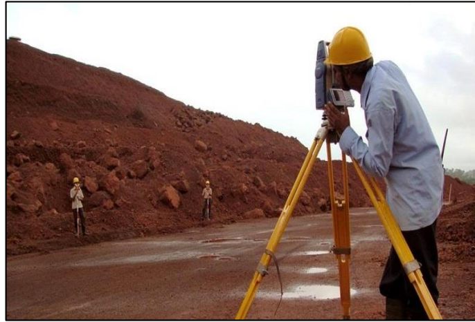
Figura 2.5 Levantamiento topográfico con estación total
