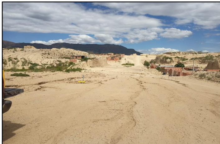
Figura 2.5 Subrasante constituida por limos plásticos y arcillas
