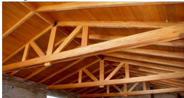
Figura 4.1 Estructura de cubierta de madera
