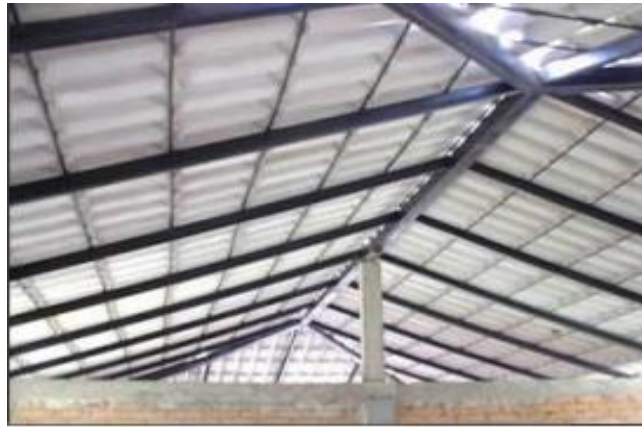
Figura 4.2 Estructura de techo conformada por perfiles laminados tipo “C”
