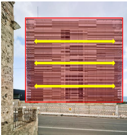
Fuente: plataforma arquitectura laboratorios y departamento de medicina
