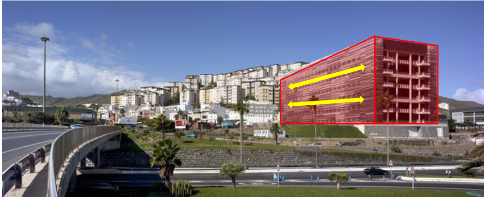
Fuente: plataforma arquitectura laboratorios y departamento de medicina
