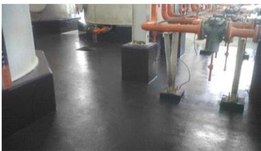
Revestimiento en pisos de cemento de uretano por sus cualidades resistentes.
