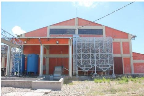
Cubierta a 2 aguas con estructura de acero y chapa metálica.
