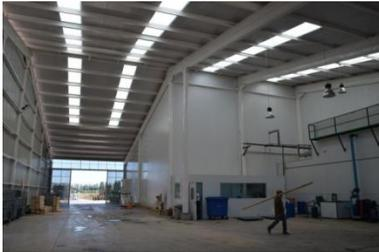
Cubierta con estructura de acero y paneles de acero trapezoidal.
