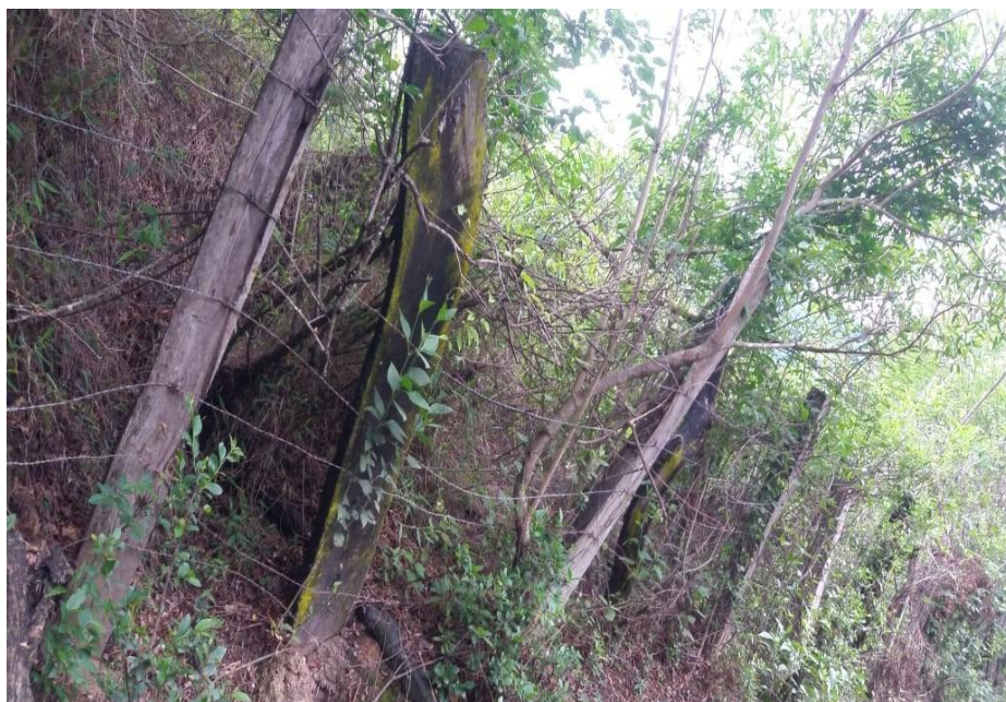
Cerco en propiedad privada en área quemada.
