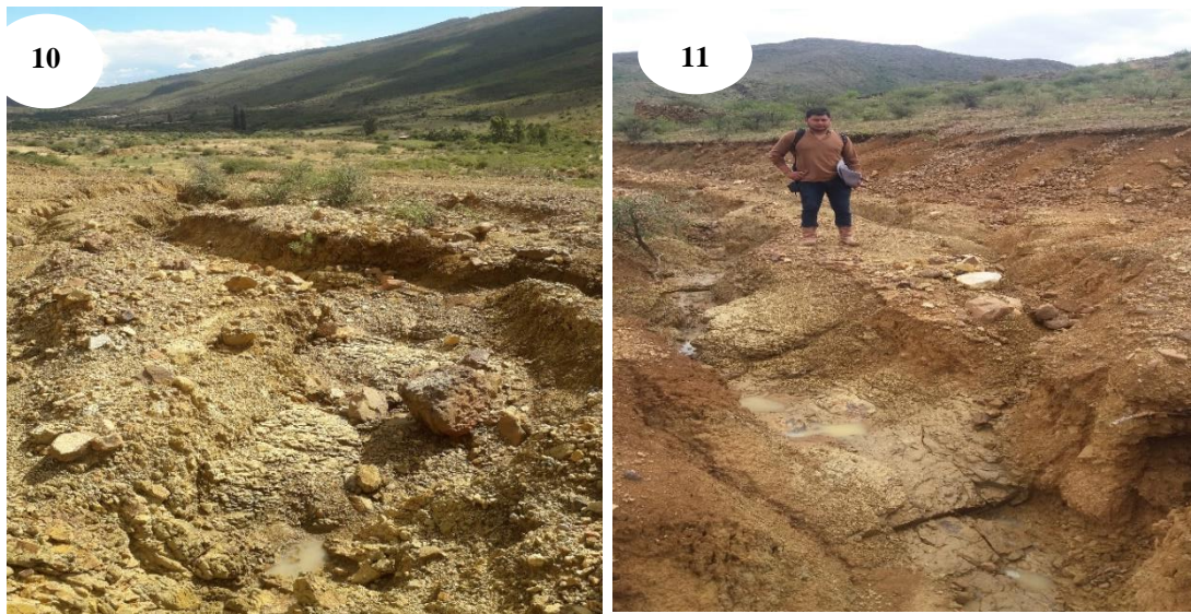
Fig. 10 y 11 Suelos con presencia de erosión en cárcavas activas provocado por socavamiento y colapso, con desprendimiento lateral de suelos, con poca vegetación y con presencia de pedregosidad
