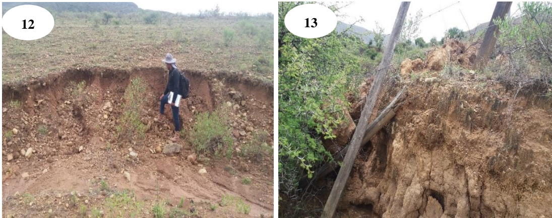
Fig. 12 y 13 Deslizamiento de suelos provocando daños en terrenos de cultivos agrícolas y terrenos de caminos por la escorrentía del agua de lluvia
