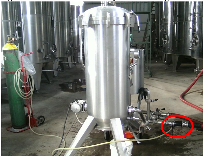
Figura 3-2: Filtro de Tierras con inyección de Nitrógeno a la salida.
