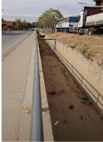
Figura 22. Naciente de la Quebrada El Monte Barrio Los Chapacos
