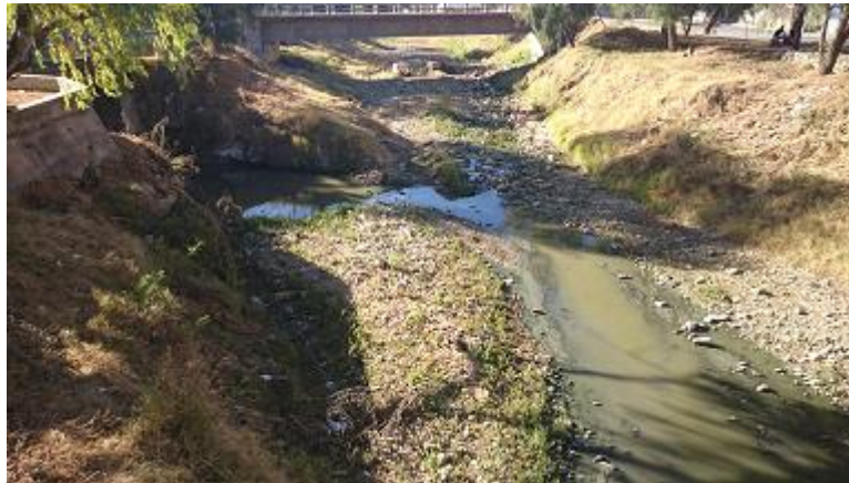
Figura 23 Descargas de aguas residuales de la Víbora Negra
