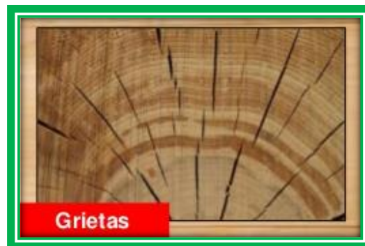
FIGURA N°12 : Grietas en una madera en estado seco
