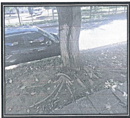
Ilustración 8 rodaje defiente con raíces expuestas
