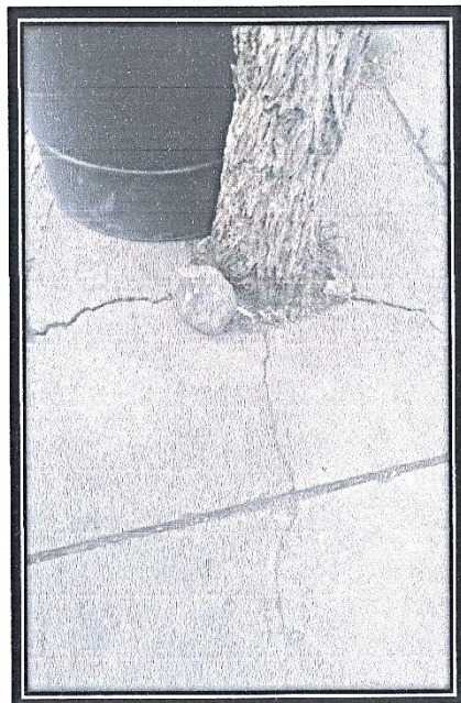
Ilustración 6 rodaje ausente
