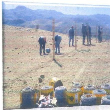
En la ilustración de las fotografías, se observa el trabajo de cerramiento perimetral. Se tomó el rendimiento para determinar la mano de obra, se hizo el control de las herramientas utilizadas y la cantidad de materiales.
