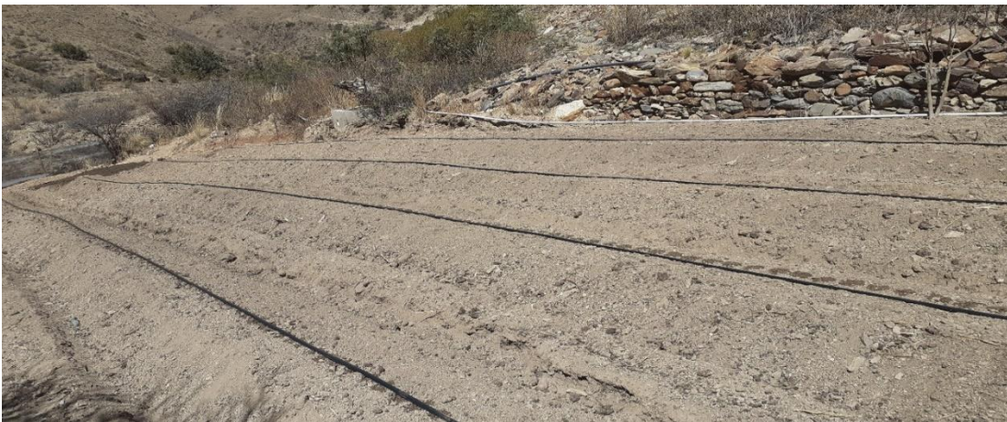
FOTO N° 13 Colocado de Manguera de Riego a Goteo por los Camellones
