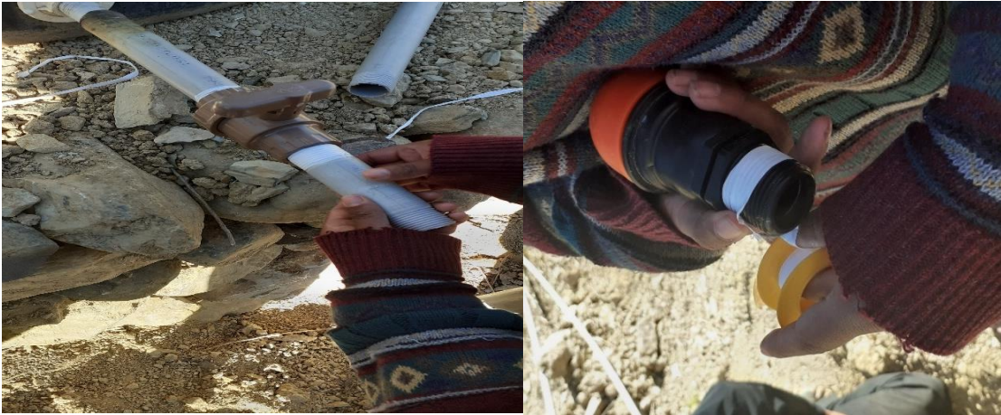
FOTO N° 8 Armado de la Cabecera de Riego
