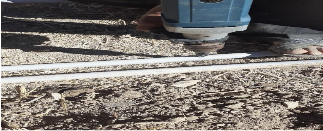
FOTO N° 12 Colocado de Conectores, Manguera Ciega y Mini Válvulas
