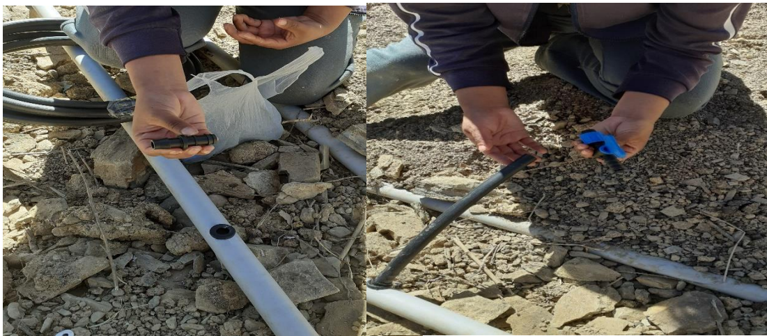
FOTO N° 13 Colocado de Manguera de Riego a Goteo por los Camellones
