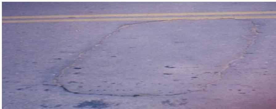
**Figura 3.17. Bacheo y Zanjas Separadas**
