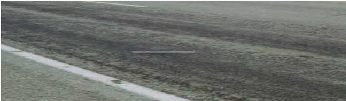
**Figura 3.13. Exudación de Asfalto**
