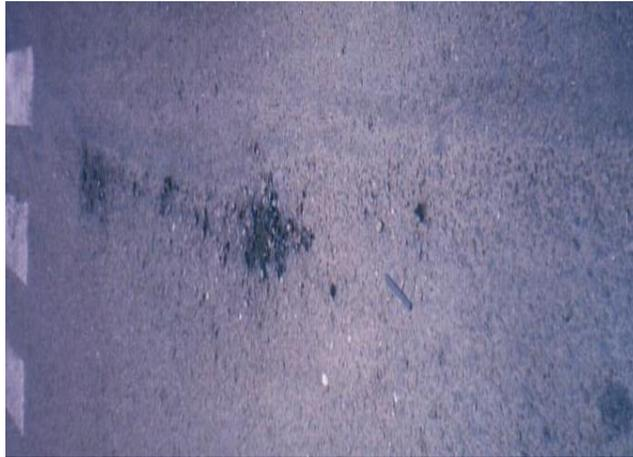
**Figura 3. 14. Disgregación y Desintegración**
