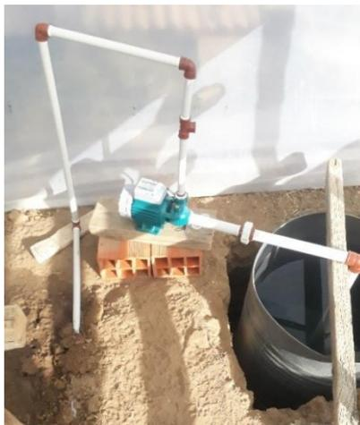
**Figura N°7. Instalación del sistema de distribución**
