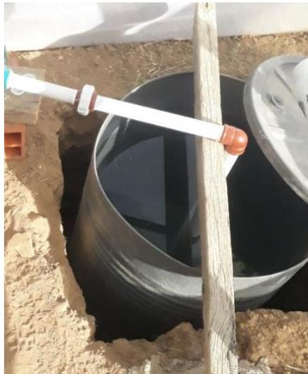
**Figura N°6. Tanque colector de la solución nutritiva**
