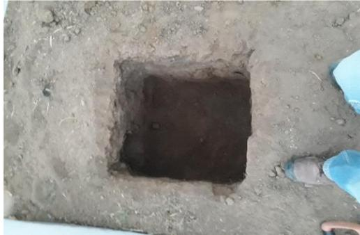
**Figura N° 2. Excavación para el tanque que almacena la solución**
