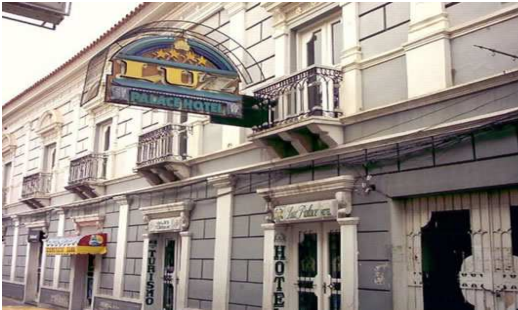
FOTO N° 2: Vista Panorámica Hotel “Luz Palace” (Parte Externa)
