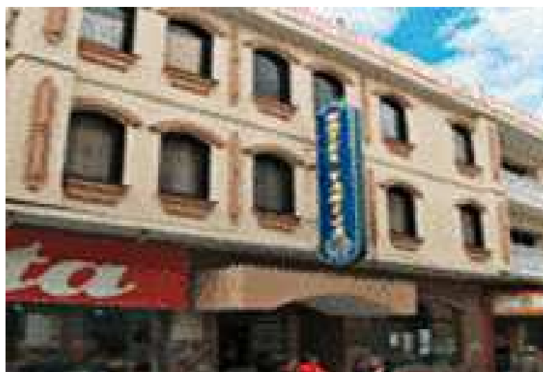
FOTO N° 1: Vista Panorámica Gran Hotel Tarija (Parte Exterior)
