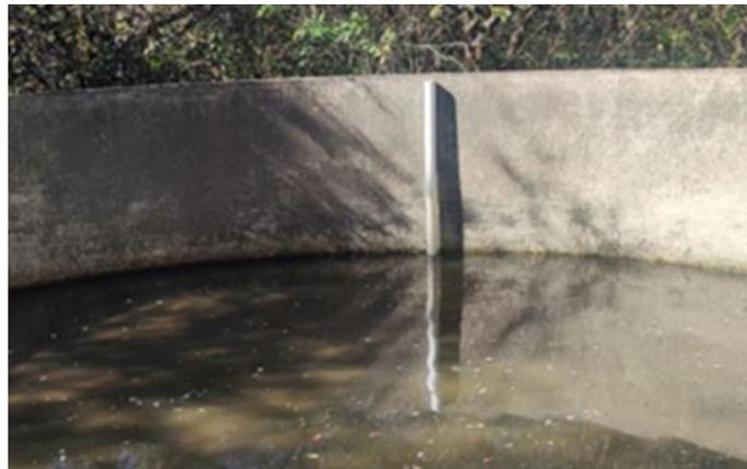
El reservorio cuenta con un tubo de saneamiento PVC de 2 pulg, que sirve para sacar el exceso de agua, como también para el mantenimiento y la limpieza del reservorio.
