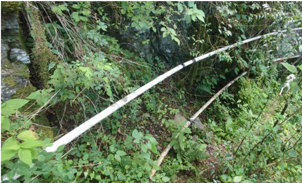
En la figura 12 podemos observar el tubo PVC de 2 pulg. encargado de conducir el agua hasta el reservorio, donde se almacena para su respectiva distribución a los productores de la comunidad.
