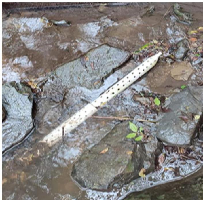
Las ranuras cuadradas en el tubo PVC se encuentran ubicados estratégicamente y con el tamaño adecuado para garantizar la eficiencia en la captación del agua para no permitir el ingreso de sedimento o restos de materia orgánica que puedan obstruir la fluides del agua en el sistema.
