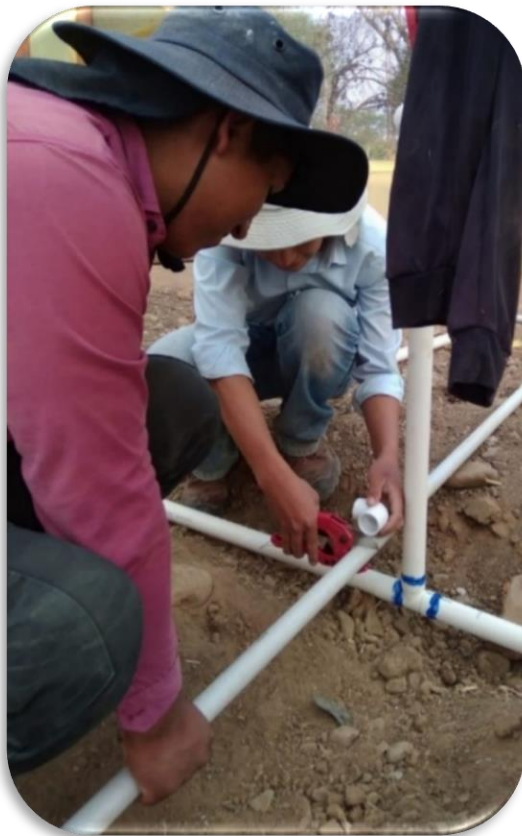
Conexión de las tuberías PVC para el sistema hidropónico
