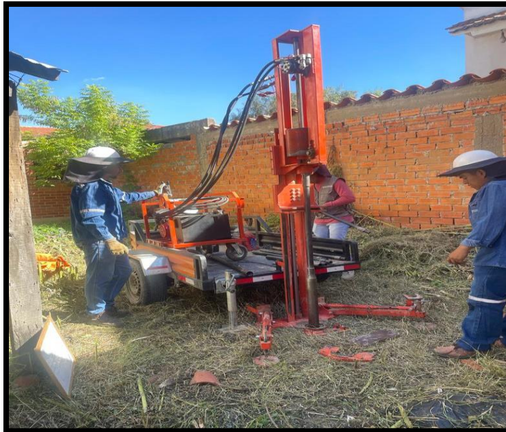
Figura 3. 3. – Fotografía del punto de perforación en el terreno
