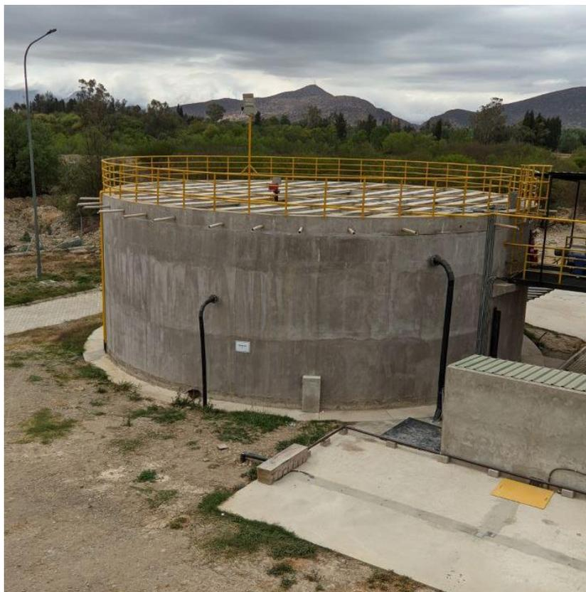
*Figura 4: Digestor anaerobio de la planta de tratamiento San Blas – Tarija, donde ocurre la digestión y tratamiento anaerobio de los lodos.*
