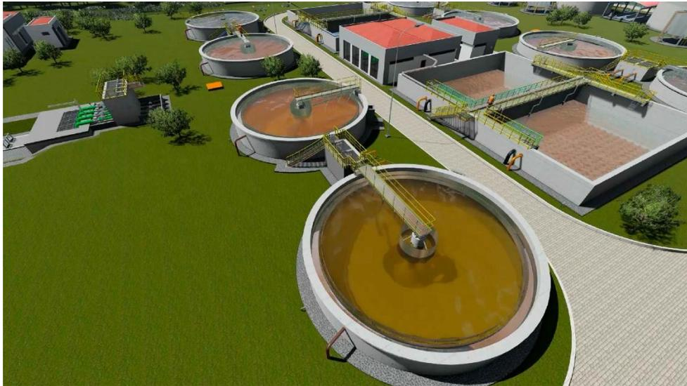
*Figura 12: Sedimentadores primarios.
