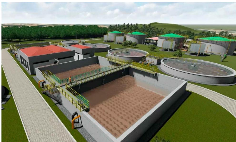
*Figura 13: Reactores biológicos y sedimentadores secundarios.
