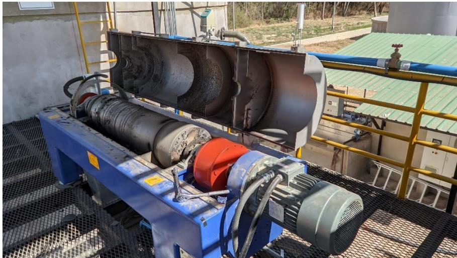
*Figura 19: Decanter de la PTAR.
