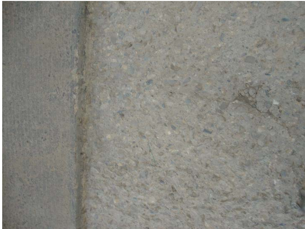
Fisura longitudinal
