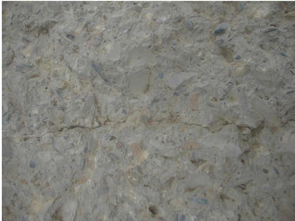
Fisura transversal
