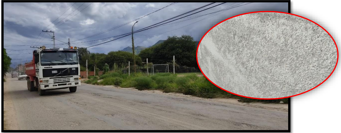
Figura 1.2 Zona de investigación, desgaste en la Avenida Los Molles
