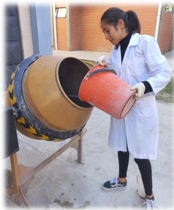
Figura 38. Elaboración de la mezcla de concreto
