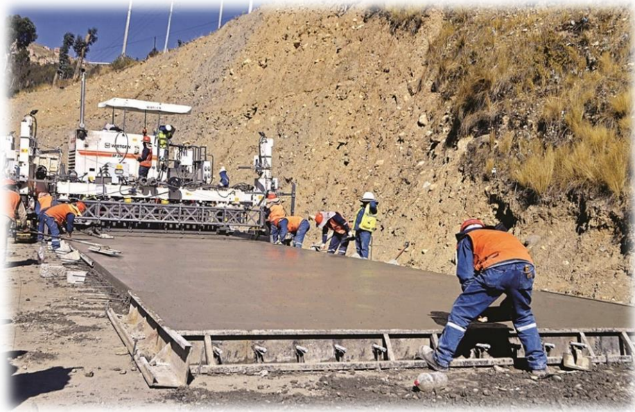
Figura 2. Construcción de pavimento rígido
