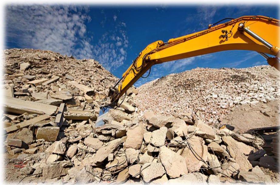
Figura 17. Reciclado de escombros de concreto
