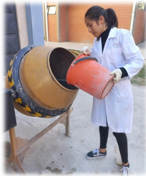
Fotografía 31 Agregando el agua para finalizar la mezcla
