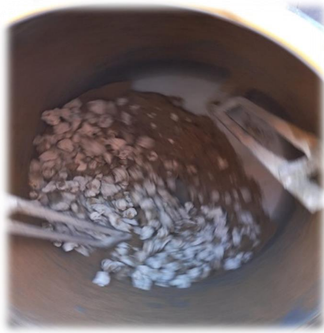
Fotografía 30 Mezclado de los agregados en seco
