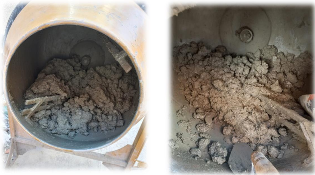
Fotografía 32 Mezcla de concreto según la dosificación definida.
