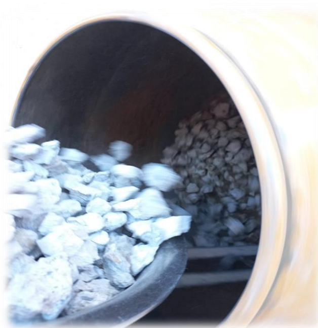
Fotografía 29 Agregado de los materiales en la mezcladora.
