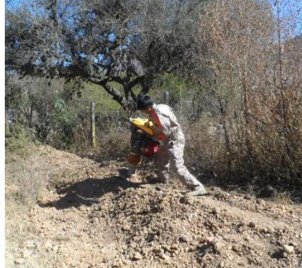
En la construcción de redes de gas la compactadora es una de las maquinas principales y de más uso, su funcionamiento depende de la dotación de gasolina, y proporciona una fuerza de impacto en los suelos cohesivos y semi cohesivos. Este equipo tiene como finalidad hacer la compactación en zanjas donde son extendidas las tuberías redes de gas.
