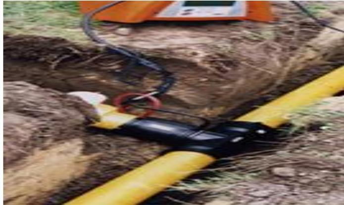
La máquina de electro fusión es un sistema de unión que se utiliza para unir las tuberías PE. Los trabajadores para asegurar una buena unión, lo que hacen es revisar primeramente la zona de la superficie del tubo para luego continuar con la raspada que es eliminar las impurezas, suciedad, grasa, etc. que puede contaminar la soldadura.
