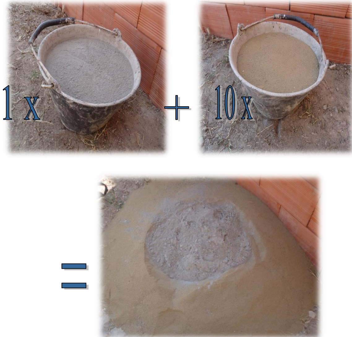
Dosificación de suelo-cemento 1:10 [Imagen 19]
