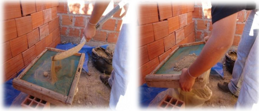
Tamizado de la tierra componente del suelo-cemento. [Imagen. 6]
