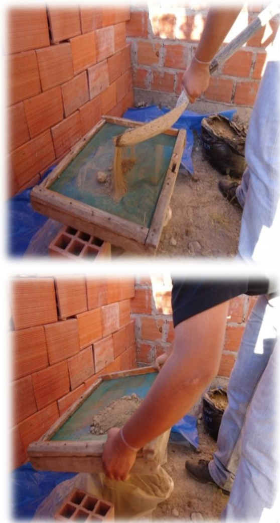
Tamizado de la tierra a través de una malla de abertura de 2mm. [Imagen 18]
