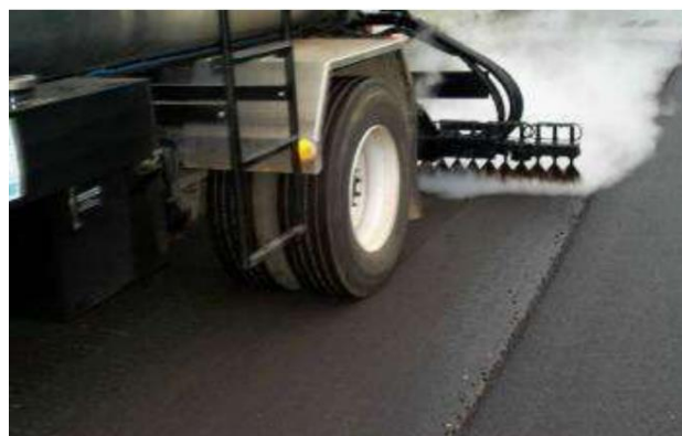
Figura 2.21. Proceso de aplicación del riego de liga
