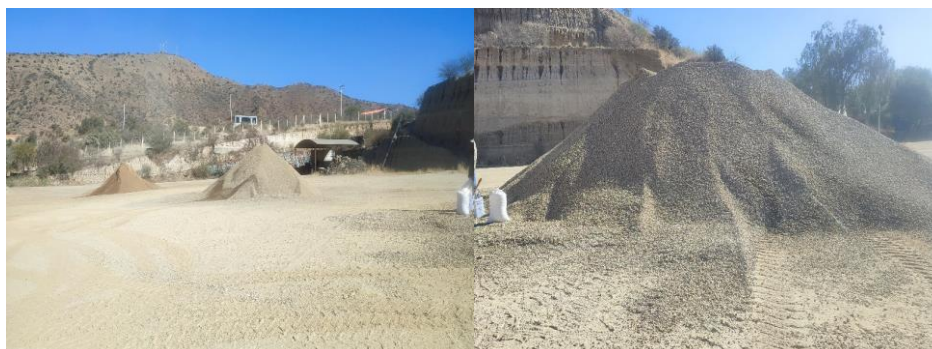
Figura 3.14. Acopio de agregados (grava, gravilla y arena) La Pintada
