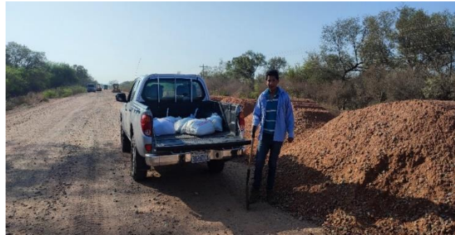
Figura 3.12. Extracción muestra de capa base de los camellones puestos en obra
