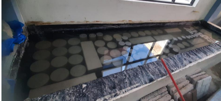
Fotografía 3.15: Curado de probetas y vigas
