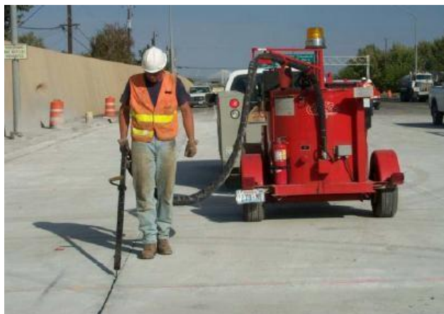
Figura 2.19: Operación Sello de Juntas
