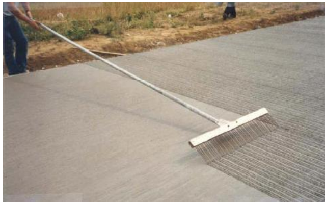
Figura 2.14: Operación de la Texturizado Final Mediante Cepillos
