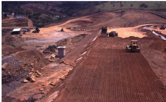
Figura 2.11: Compactación de la Subrasante con Rodillo Pata de cabra
