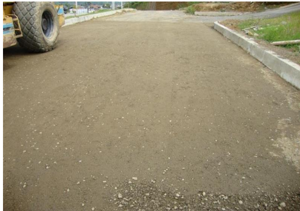
Figura 2.12: Acabado y Compactado de la Capa
