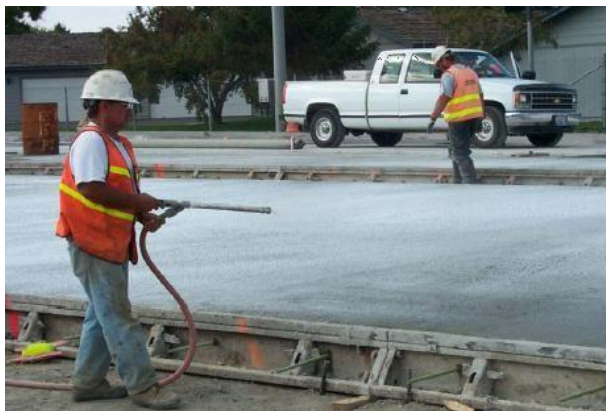
Figura 2.15: Operación del Curado del Pavimento Rígido
