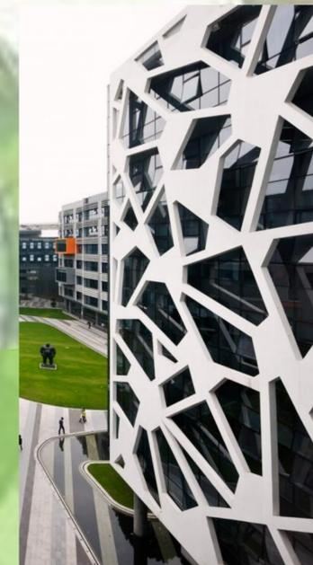
El sistema estructural de doble fachada, es una solución constructiva que consiste en instalar una segunda capa de fachada sobre la fachada misma, creando una cámara de ventilación entre el muro y el revestimiento exterior.
