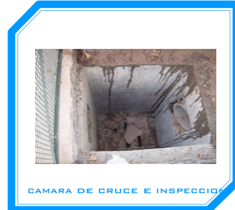
CAMARA DE CRUCE E INSPECCION
