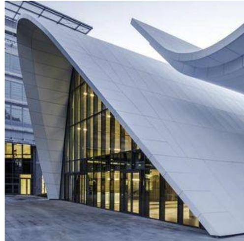
El panel de aluminio constructo se compone de un núcleo termoplástico de polietileno de baja densidad ubicado entre dos láminas de aluminio con un grosor de 0.5 mm . Las superficies son rígidas, con un módulo alto de elasticidad.
